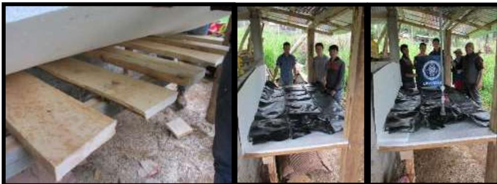
Figura 12. Tarima cubierta con tecnopor sobre la que se instaló el gasómetro.
