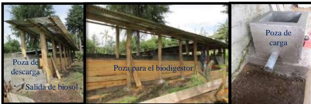
Figura 5. Infraestructura para instalar el biodigestor constituida por la poza de descarga de biol, tubería de fondo para salida de biosol, poza de 10 m de largo hecha de madera para el biodigestor y poza de carga o alimentación del biodigestor.
