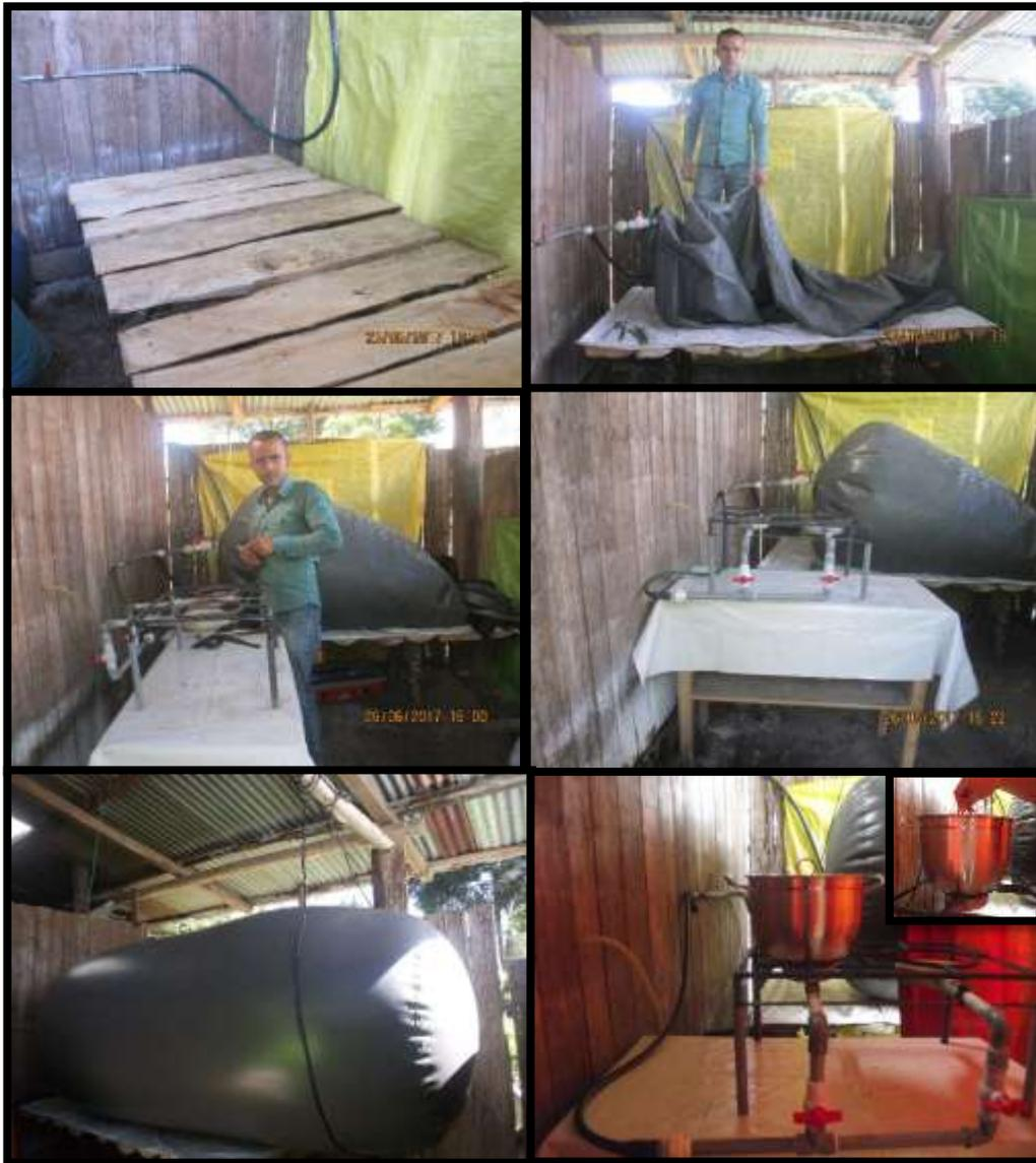
Figura 20. Instalación de gasómetro adicional en el ambiente de la cocina.
