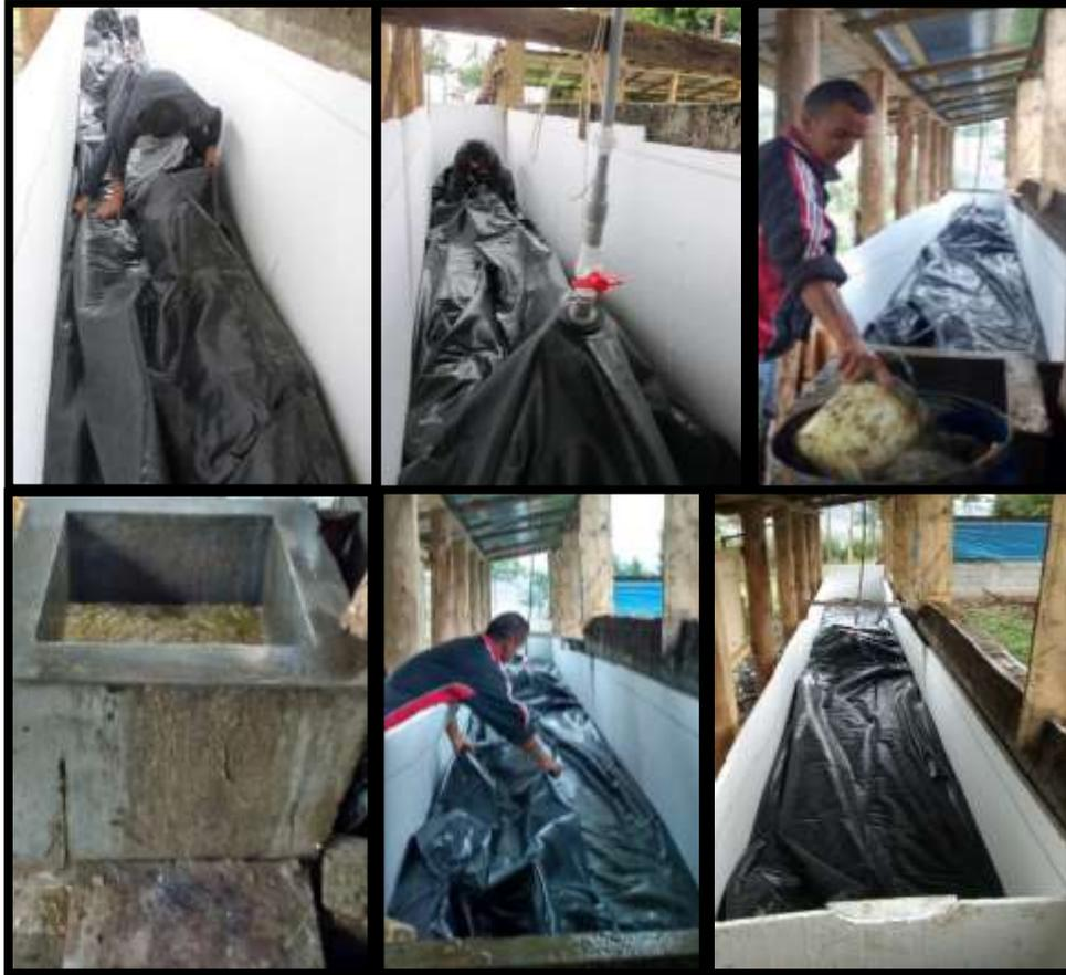
Figura 16. El nivel hasta donde se cargó el biodigestor debe cubrir la boca del tubo en ambas pozas (de carga y descarga). Conforme se va cargando el biodigestor, se lo debe ir jalando hacia arriba y a todo lo largo para que se despliegue y se llene uniforme.
