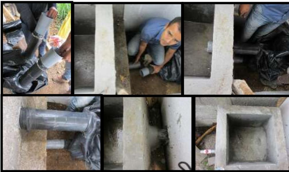
Figura 11. Instalación del biodigestor a la tubería de fondo para salida de biosol y a la poza para salida de biol. Los tubos se fijaron con “diablo”.
