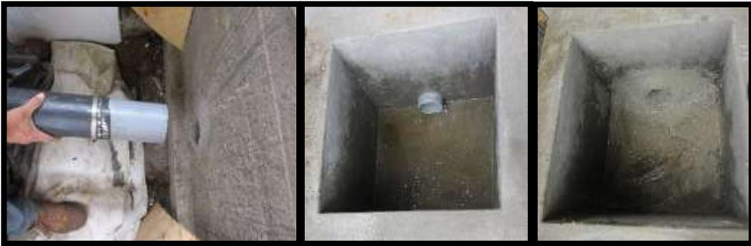
Figura 8. Instalación del biodigestor a la poza de carga o alimentación y fijación del tubo con “diablo” (mezcla 1:1 de cemento con yeso) que fragua rápidamente.
