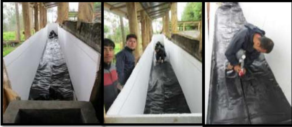
Figura 10. Biodigestor en la poza y colocación de la llave para salida de biogas.
