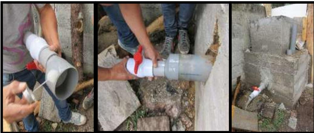
Figura 9. Colocación de la llave de paso de 2” con reducción de 4” a 2” para salida de biosol y fijación del tubo con “diablo”.
