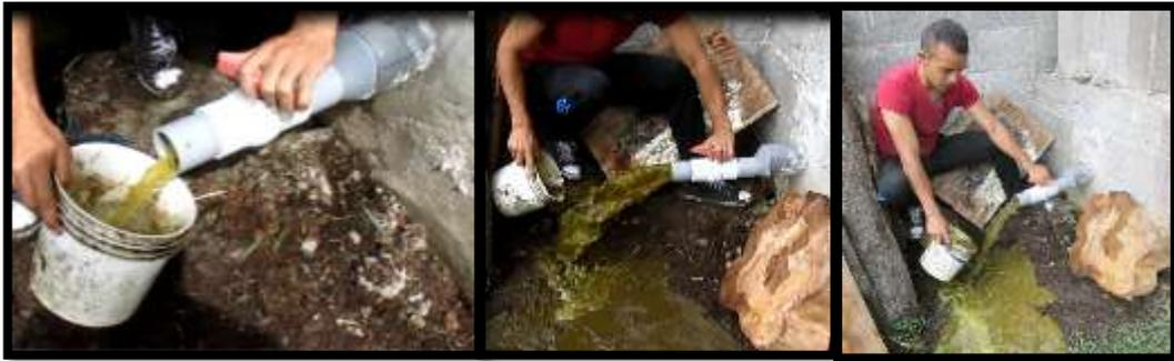
Figura 24. Retiro de biosol del biodigestor.
