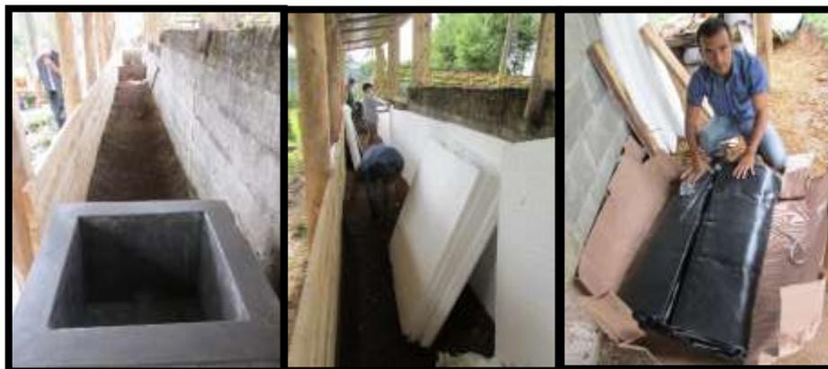
Figura 6. Colocación de tecnopor como aislante térmico y protector del biodigestor.
