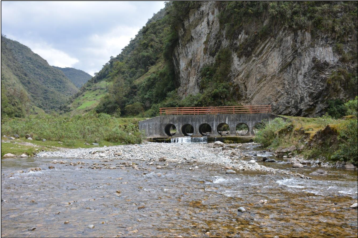
Figura 20: Puente que conecta la vía de acceso para los centros poblados establecidos en la parte alta de la microcuenca Atuen
