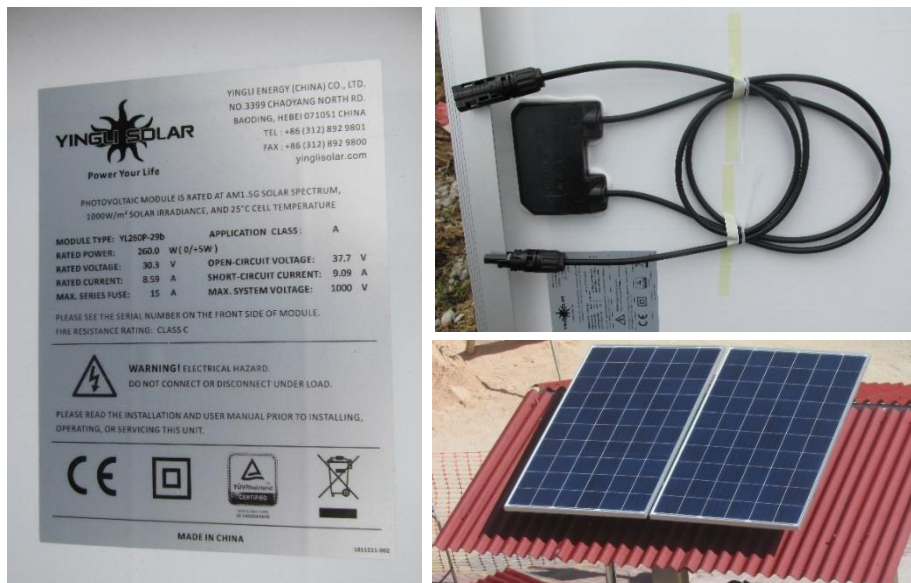
Figura 1. Ficha técnica, caja de conexión con cables (terminal positivo y negativo) y superficie de captación de los paneles fotovoltaicos de 260 Wp.
