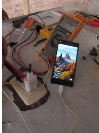
Figura 10. Prueba de funcionamiento del sistema fotovoltaico.
