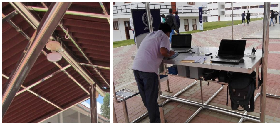
Figura 11. Foco LED de 8 W, carga de las baterías de laptops y teléfonos celulares.
