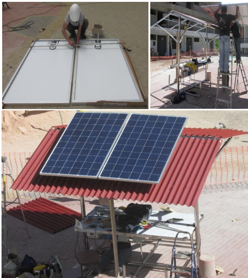
Figura 5. Montaje de los paneles fotovoltaicos.
