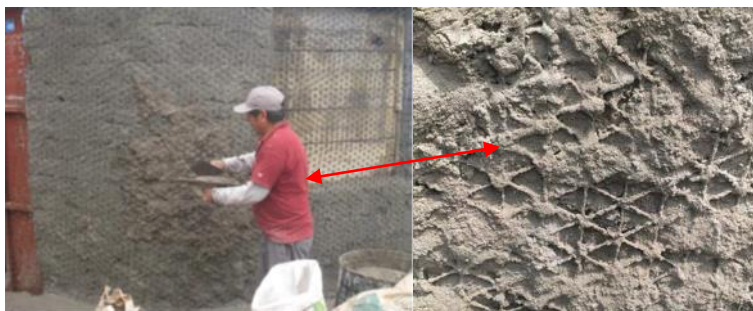
Figura 31. Tarrajeo de muro reforzado con geomalla.
