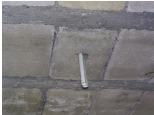
Figura 40. Ubicación de cajas de octogonales para los centros de luz
