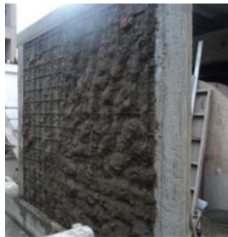
Figura 28. Tarrajeo de muros.
