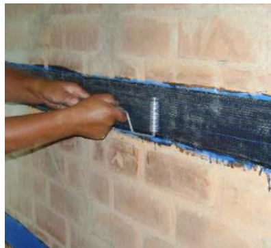
Figura 34. Colocación de fibra de carbono.
