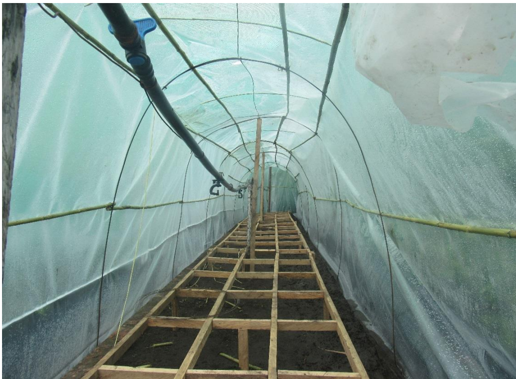
Fotografía 1. Instalación del invernadero
