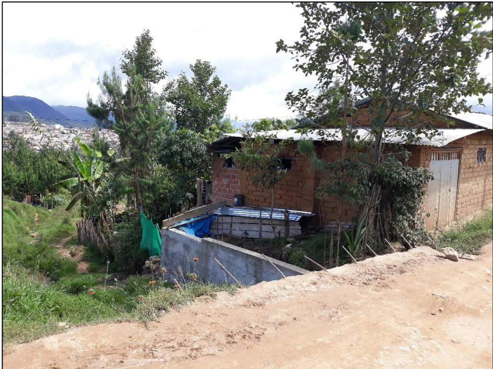
Foto 6. Vivienda ubicada a rivera de la quebrada de Murcia (margen derecho).
