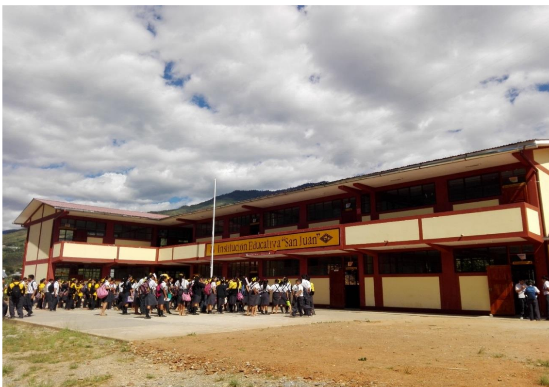
Vista frontal de la I. E. San Juan de Ocumal.
