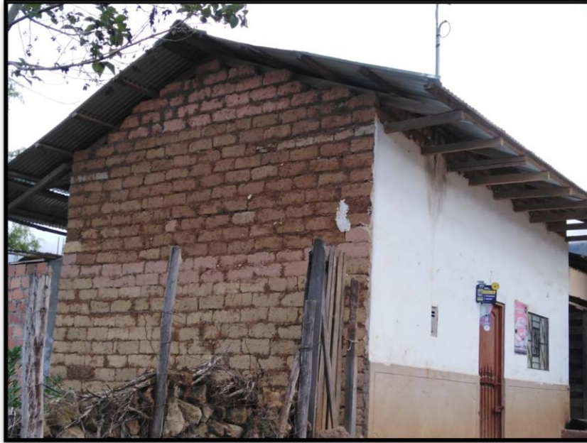
Figura 41. Vivienda de material de adobe, techo de calamina y con servicios básicos de saneamiento
