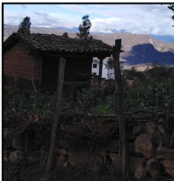
Figura 39. Vivienda típica de la zona en mal estado y sin servicios básicos de saneamiento
