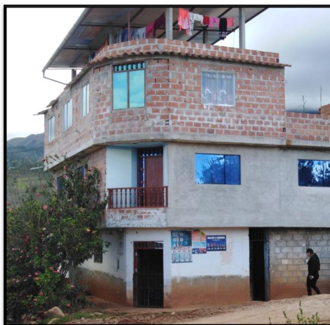
Figura 40. Vivienda de albañilería informal de tres pisos y sin servicios básicos de saneamiento
