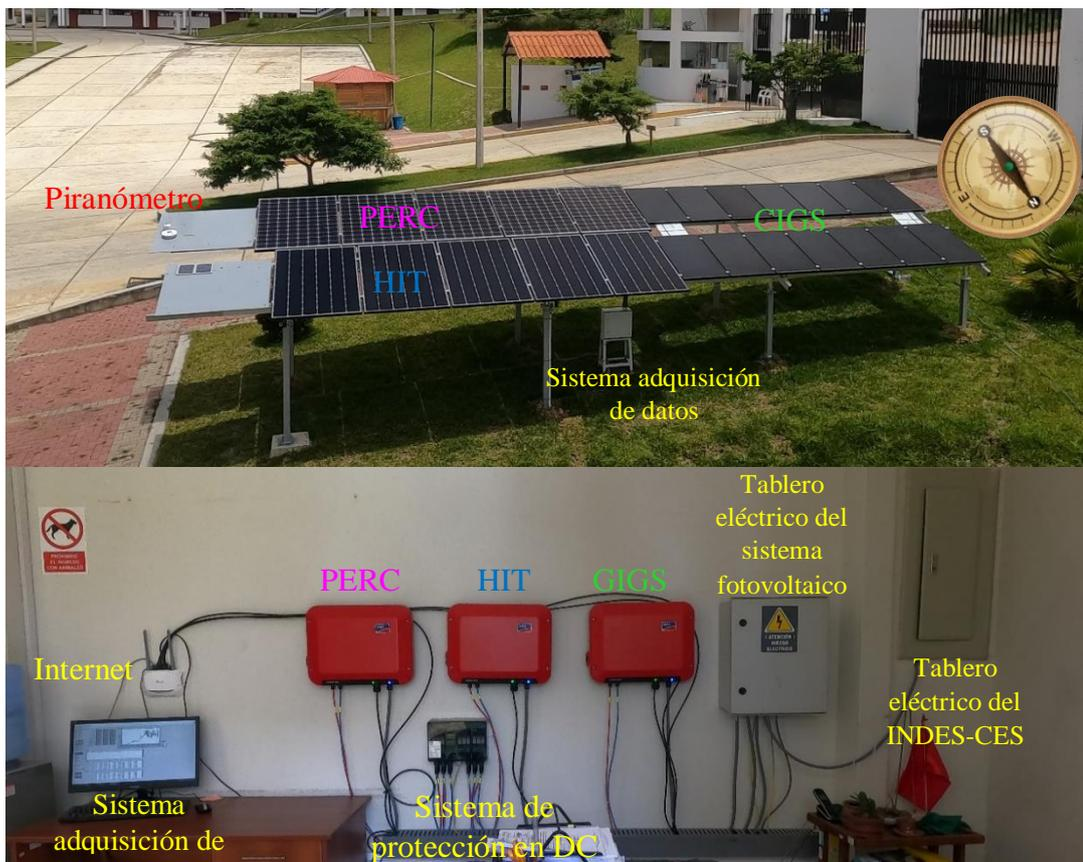
**Figura 6.** Sistemas fotovoltaicos instalados
