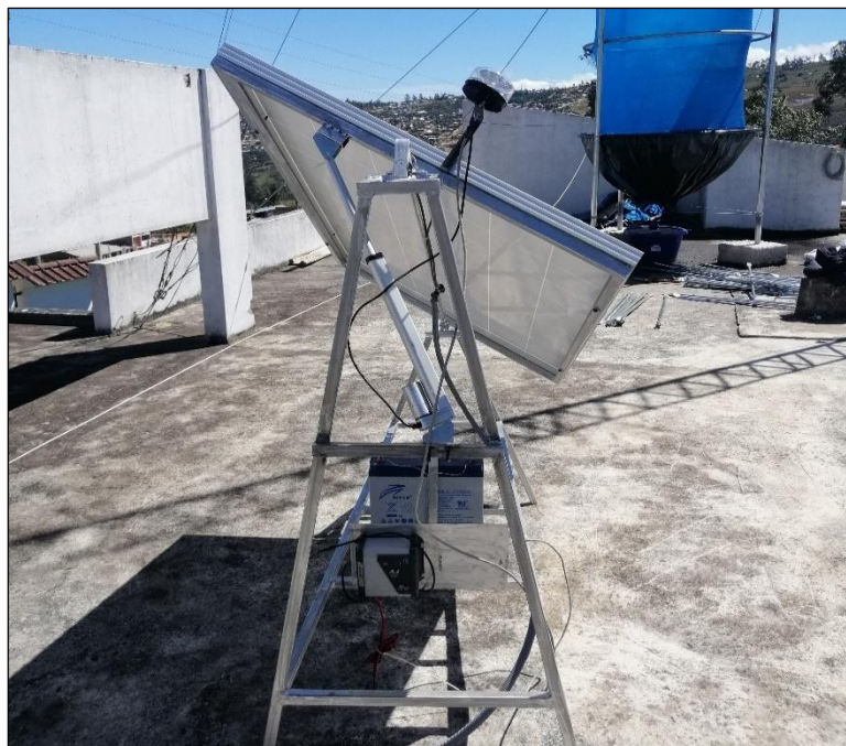
Figura 13. Sistema fotovoltaico con seguidor solar
