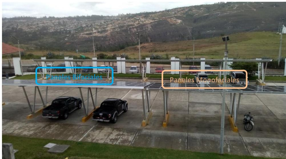
Figura 10. Ubicación e instalación de los sistemas de paneles solares – Sede administrativa
