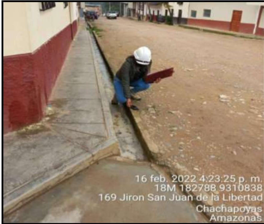
**Foto 04.** Levantamiento topográfico: Toma de datos con GPS en el Jr. San Juan de la Libertad Cuadra 01 (Jr. Salamanca cuadra 01).
