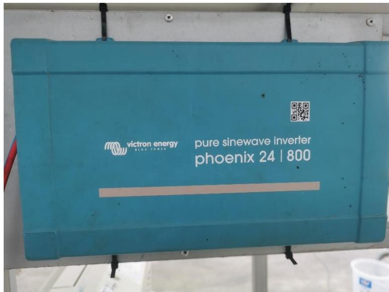
**Figura 7.** Inversor del sistema fotovoltaico
