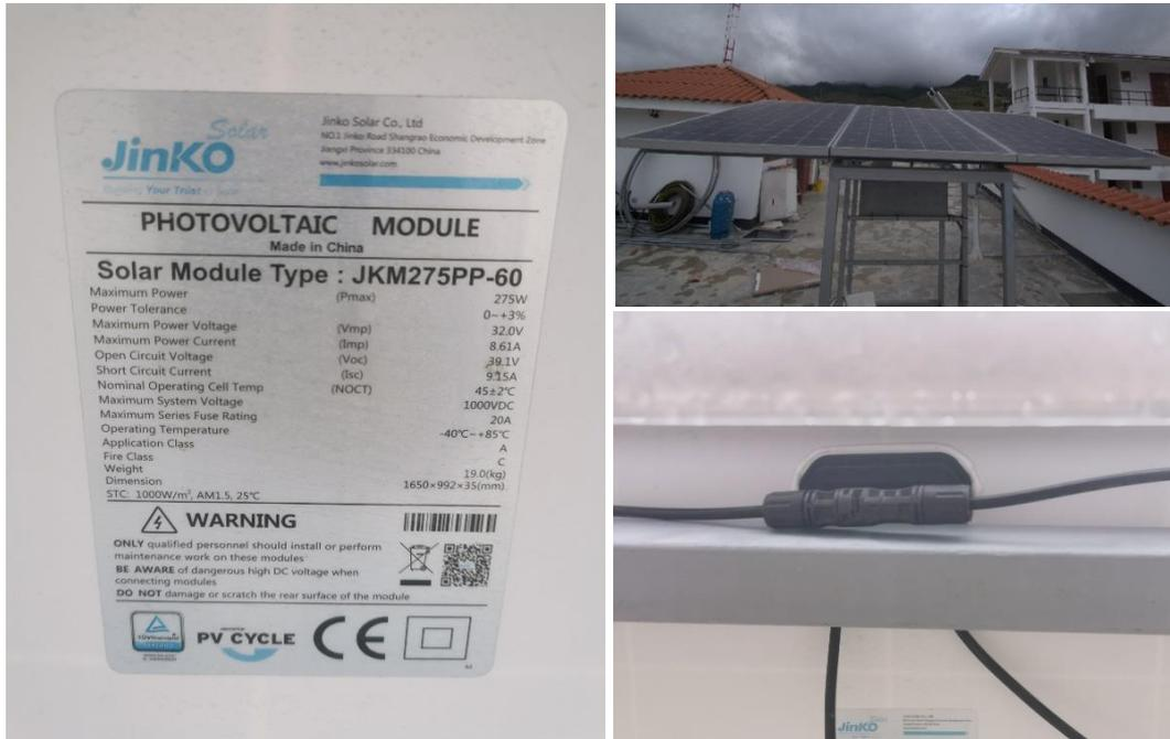
**Figura 4.** Ficha técnica, caja de conexión con cables (terminal positivo y negativo) y superficie de captación de los paneles fotovoltaicos de 275 Wp.
