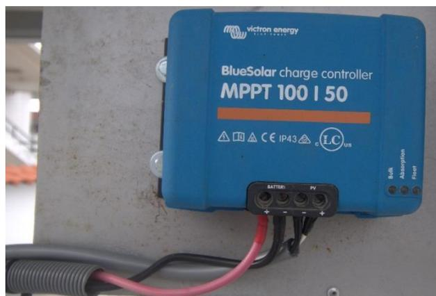
**Figura 5.** Regulador de carga del sistema fotovoltaico
