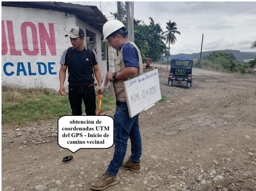
Nota: se ha utilizado GPS para la obtención de puntos UTM y para georreferenciar las unidades de muestra, además para elaborar plano clave de la ubicación de fallas registradas.
