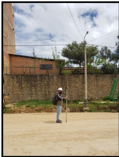
Fotografía N° 14. Toma de puntos topográficos en la Vía de Evitamiento.
