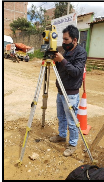
Fotografía N° 13. Puesta de la 2da Estación en la Vía de Evitamiento.
