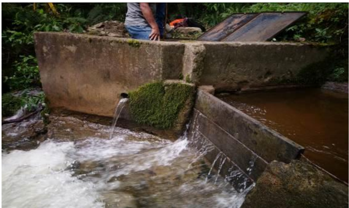
Figura 20: Estructuras existentes de la captación
