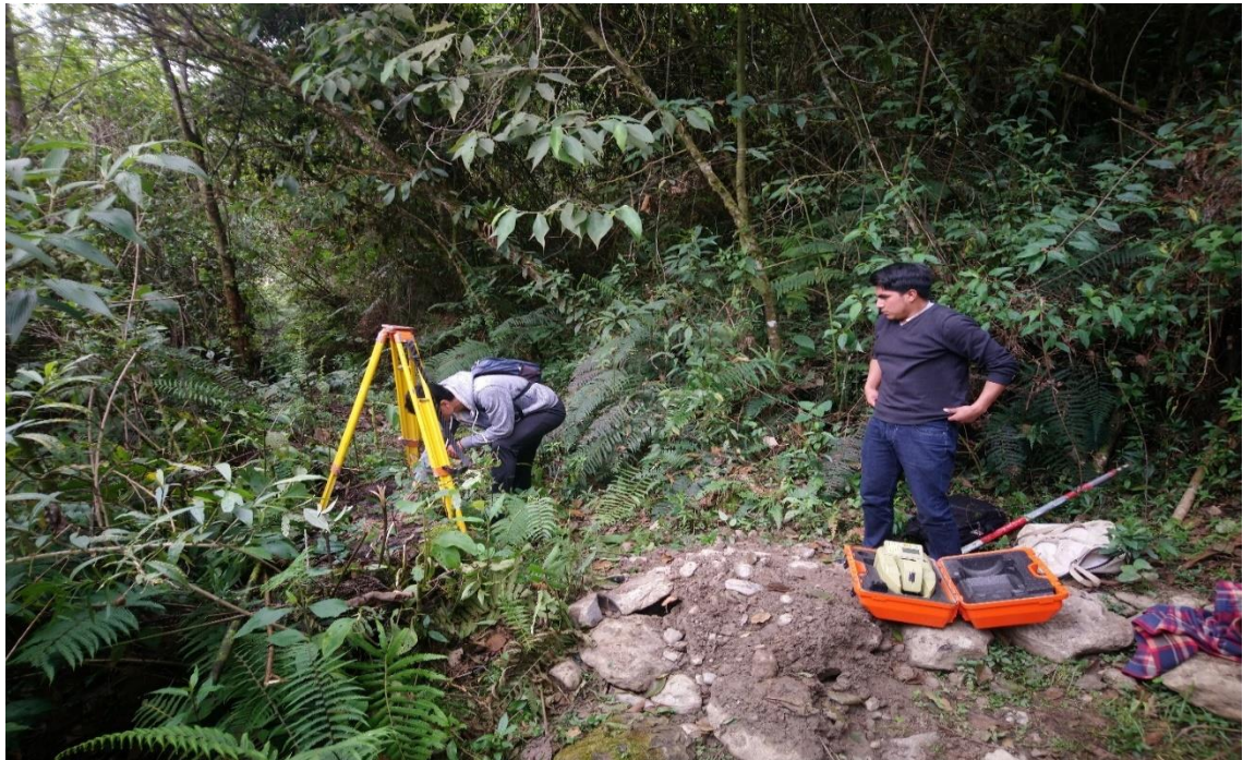
Figura 19 Levantamiento topográfico de la línea de condición
