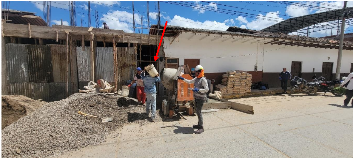
Imagen 1: Se evidencia la forma en la que se realizó la medida de la dosificación utilizada por cada vivienda.
