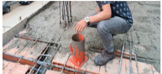
Imagen 5: recolección de muestra del concreto vaciado en las losas aligeradas, para ser evaluadas en laboratorio a los 28 días.
