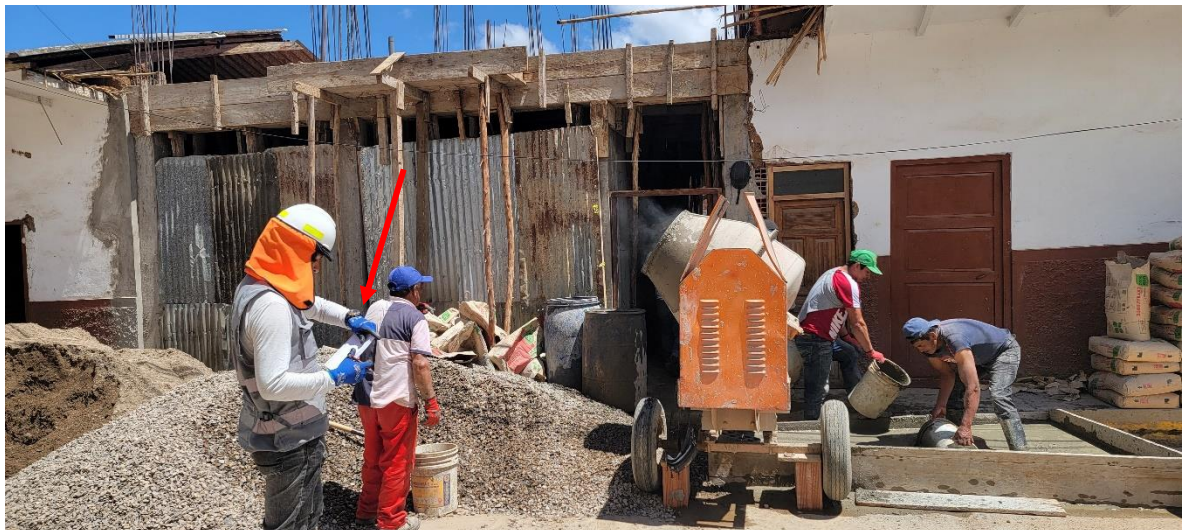
Imagen 2: Se evidencia la forma en la que se realizó la medida del tiempo de mezclado.
