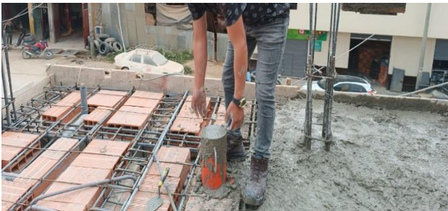
Imagen 5: recolección de muestra del concreto vaciado en las losas aligeradas, para ser evaluadas en laboratorio a los 28 días.
