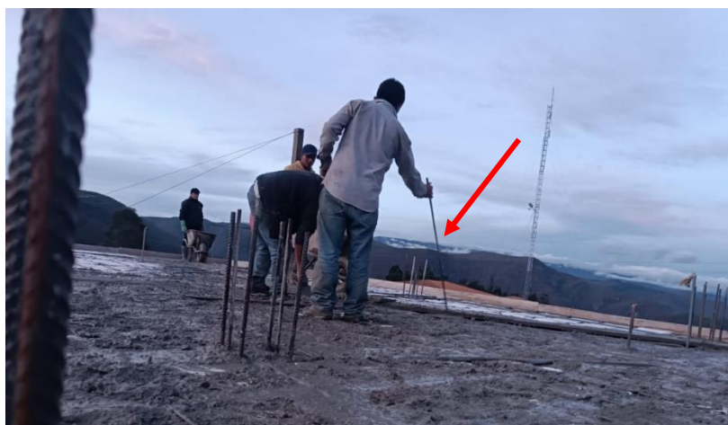
Imagen 3: Se muestra el tipo de chuzado realizado en obra.
