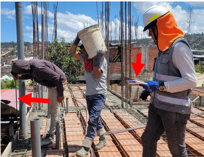
Imagen 4: se muestra la forma de control del Chuzado.
