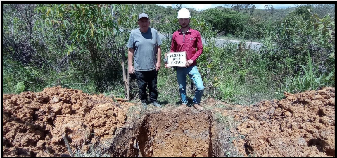
Fotografía N° 7. Excavación de la calicata (C-2), 2.50 m de profundidad.
