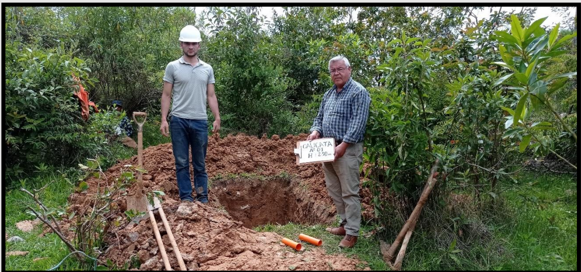
Fotografía N°4. Excavación de la calicata (C-1), 2.50 m de profundidad.
