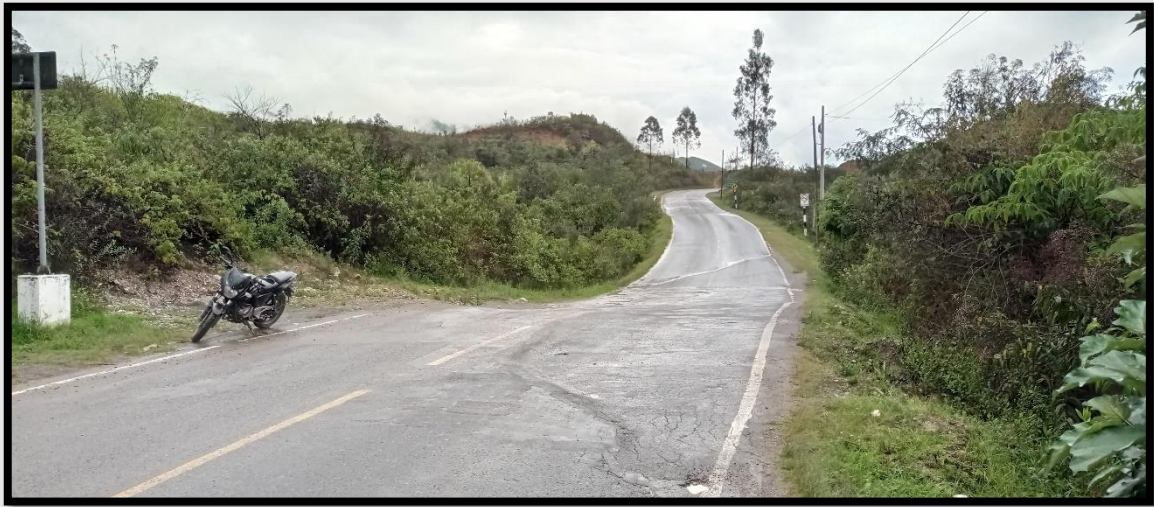
Fotografía N° 1. Estado actual del lugar de investigación.
