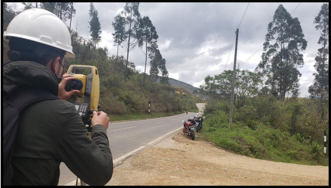
Fotografía N° 3. Levantamiento topográfico del lugar de estudio con la ayuda de estación total.
