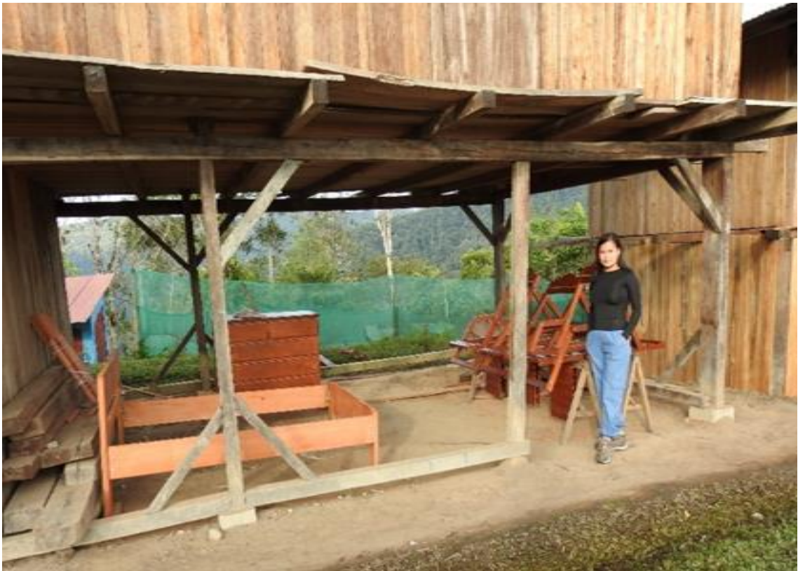
Fotografía 1. Visita a carpintería en el C.P. La Perla del Imaza.
