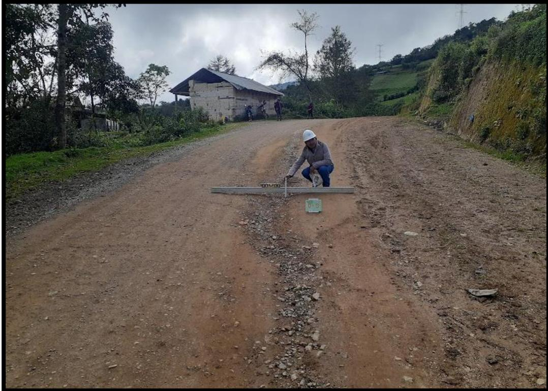
**Figura 25.** Erosión gravedad 1: Profundidad 4.30 cm, en el Km 10+480
