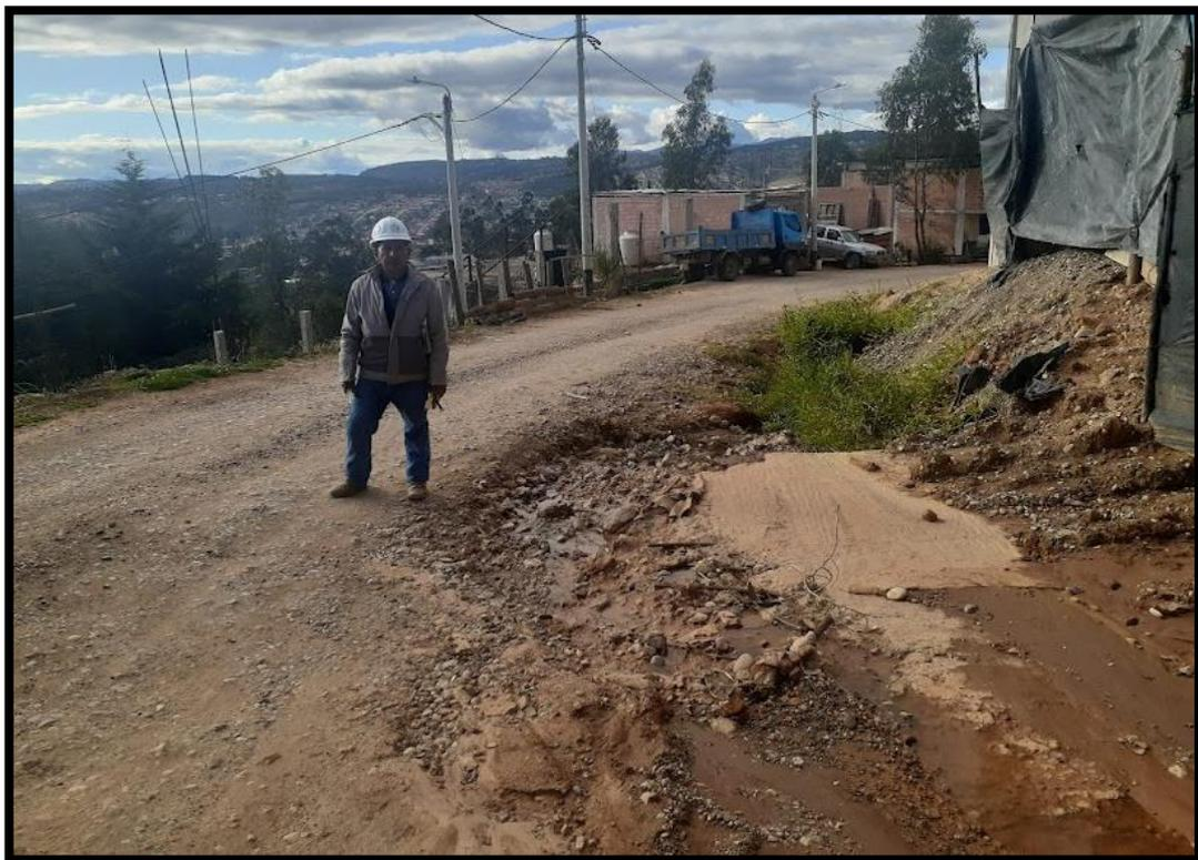
**Figura 24.** Erosión gravedad 2: Profundidad 5.90 cm, en el Km 0+590
