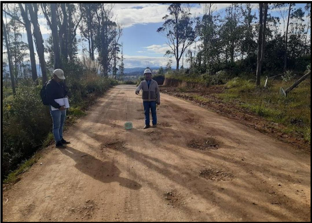
**Figura 28.** Baches gravedad 1 y 2: Se evidencian baches de gravedad 1 y 2 en el Km 2+200 el cual dificulta el tránsito de los vehículos y genera malestar a los usuarios.
