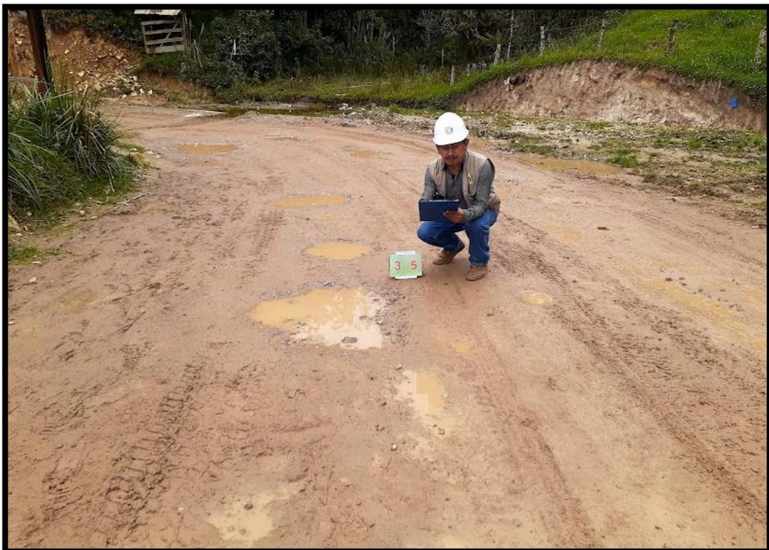
**Figura 32.** Baches gravedad 1 y 2: Se evidencian baches de gravedad 1 y 2 en el Km 20+250
