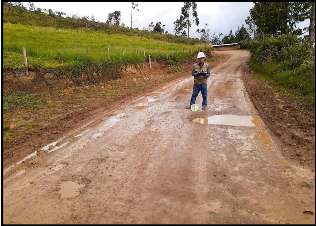
**Figura 31.** Baches gravedad 1 y 2: Se evidencian baches de gravedad 1 y 2 en el Km 13+100
