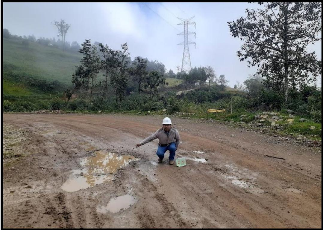
**Figura 29.** Baches gravedad 1 y 2: Se evidencian baches de gravedad 1 y 2 en el Km 10+740
