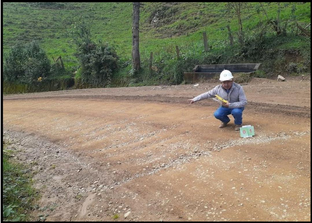
**Figura 33.** Encalaminado gravedad 1: Profundidad 3.50 cm, en el Km 10+100
