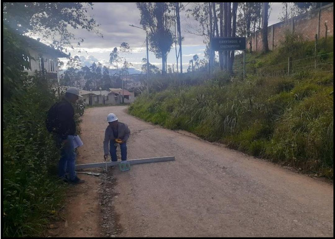
**Figura 23.** Erosión gravedad 2: Profundidad 7.50 cm, en el Km 0+200
