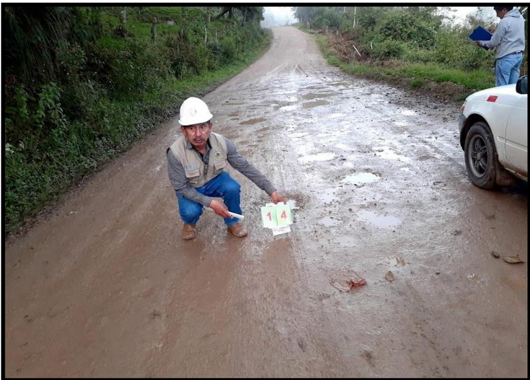
**Figura 30.** Baches gravedad 1: Se evidencian baches de gravedad 1, en el Km 12+080
