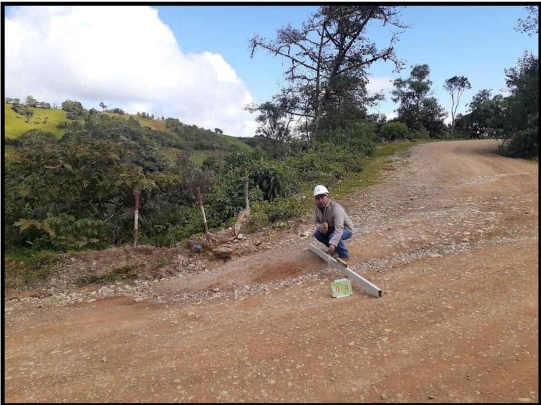
**Figura 26.** Erosión gravedad 2: Profundidad 5.1 cm, en el Km 11+360
