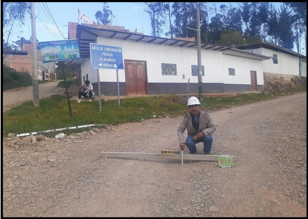
**Figura 19.** Deformación gravedad 2: Profundidad 6.80 cm, en el Km 0+005.
