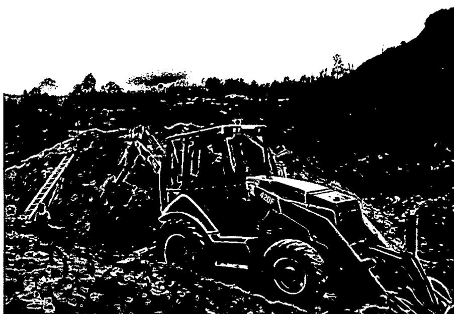
*Figura 17:* Excavación de zanja en terreno suelto con retroexcavadora Cat 420F.
