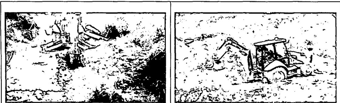
**Imagen 08:** *En las imágenes se puede observar a la retroexcavadora Cat 420F excavando zanja en terreno semi rocoso.*
