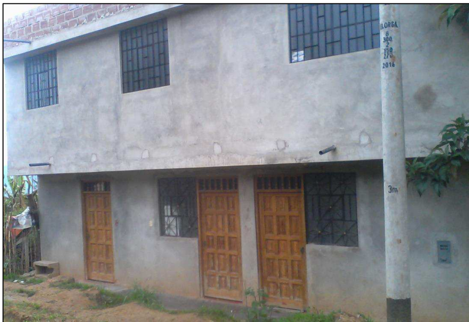
Figura N° 55: Vivienda de la familia Zuta Gómez construida de dos pisos (elaboración propia)
