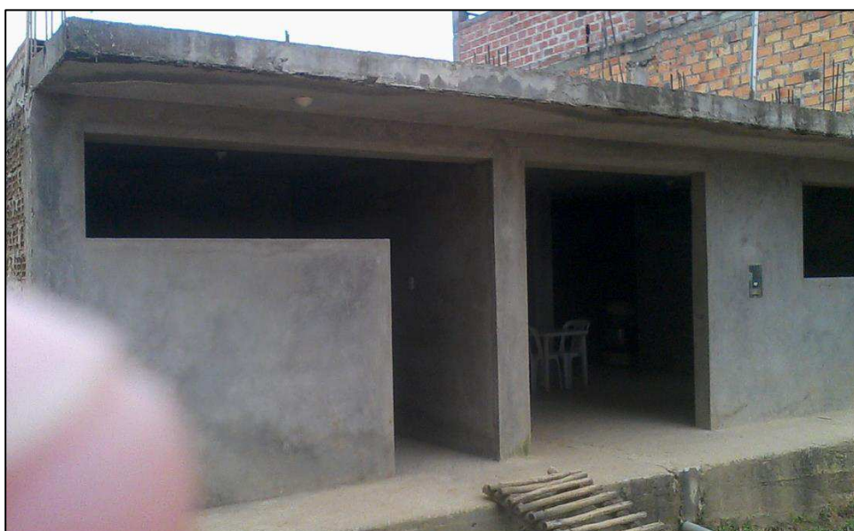
Figura N° 61: Vivienda de la familia Arbildo Torres en buenas condiciones (elaboración propia)
