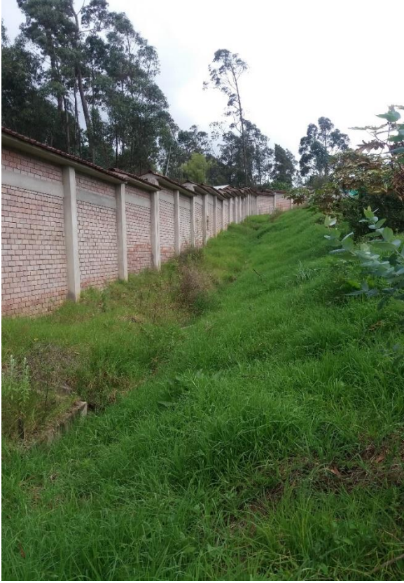
Fotografía 8: Estructuras de drenaje pluvial sin mantenimiento
