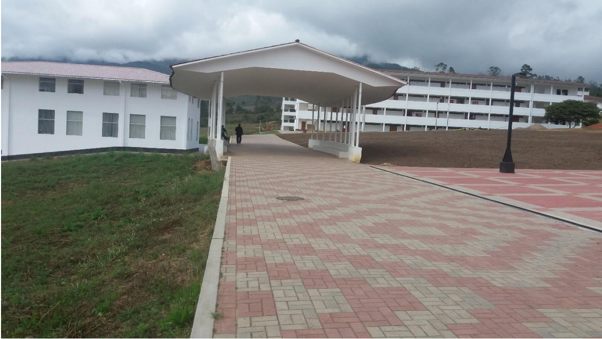
Fotografía 17: Área donde se enterraron Estructuras de drenaje pluvial.
