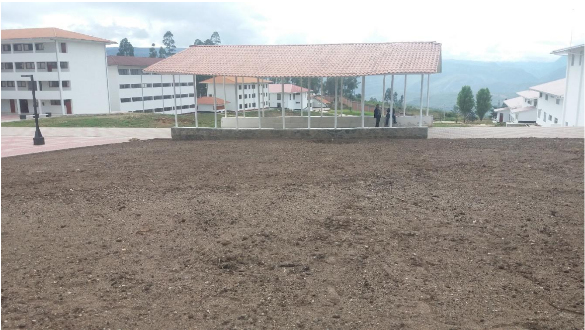
Fotografía 16: Área donde se enterraron Estructuras de drenaje pluvial.
