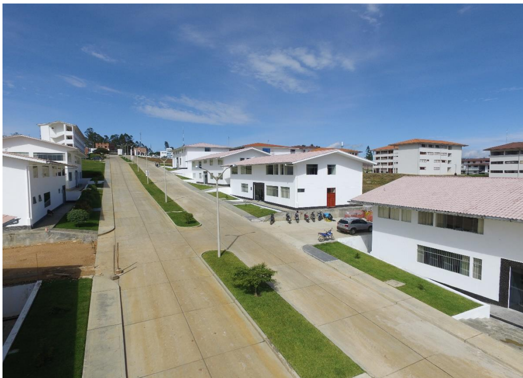
Fotografía 1: Pistas con pocas estructuras de drenaje pluvial
