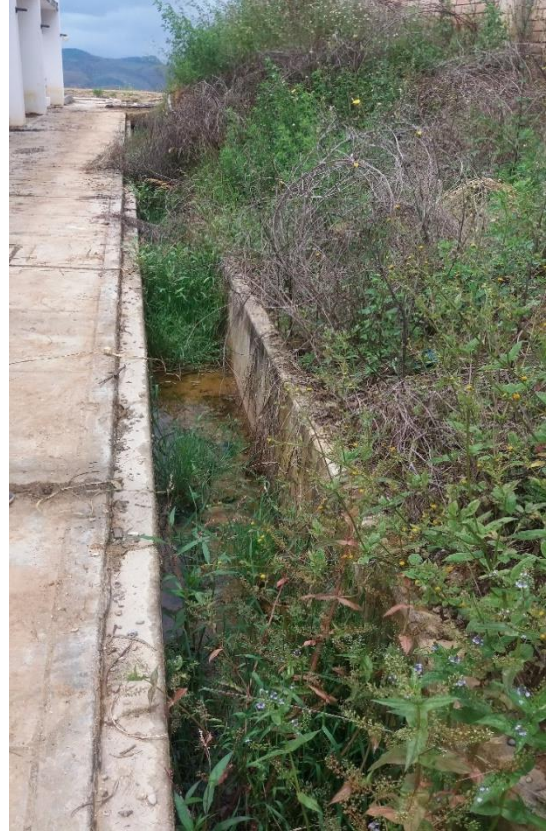
Fotografía 8: Estructuras de drenaje pluvial sin mantenimiento
