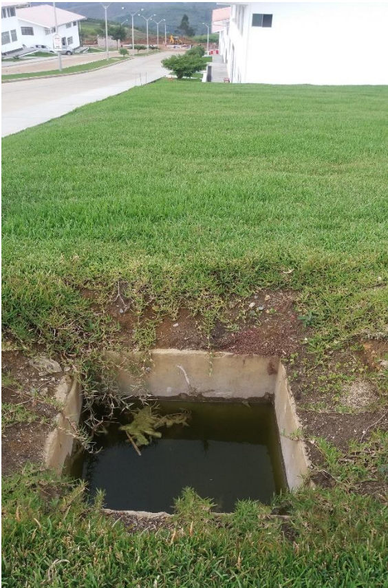
Fotografía 5: Estructuras de drenaje pluvial en mal estado y sin funcionamiento
