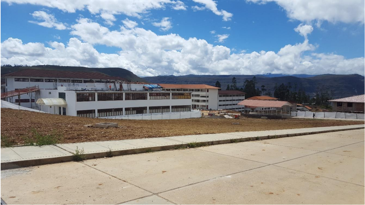
Fotografía 13: Estructuras de drenaje pluvial antes de ser enterradas.
