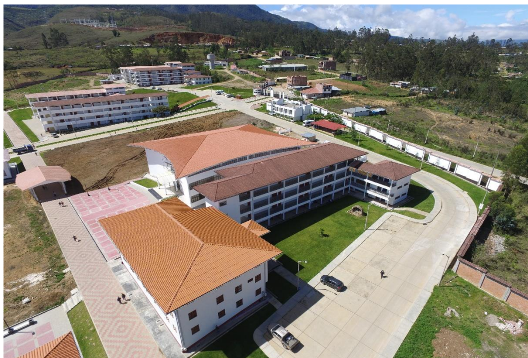
Fotografía 2: Pistas y adoquinados con pocas estructuras de drenaje pluvial
