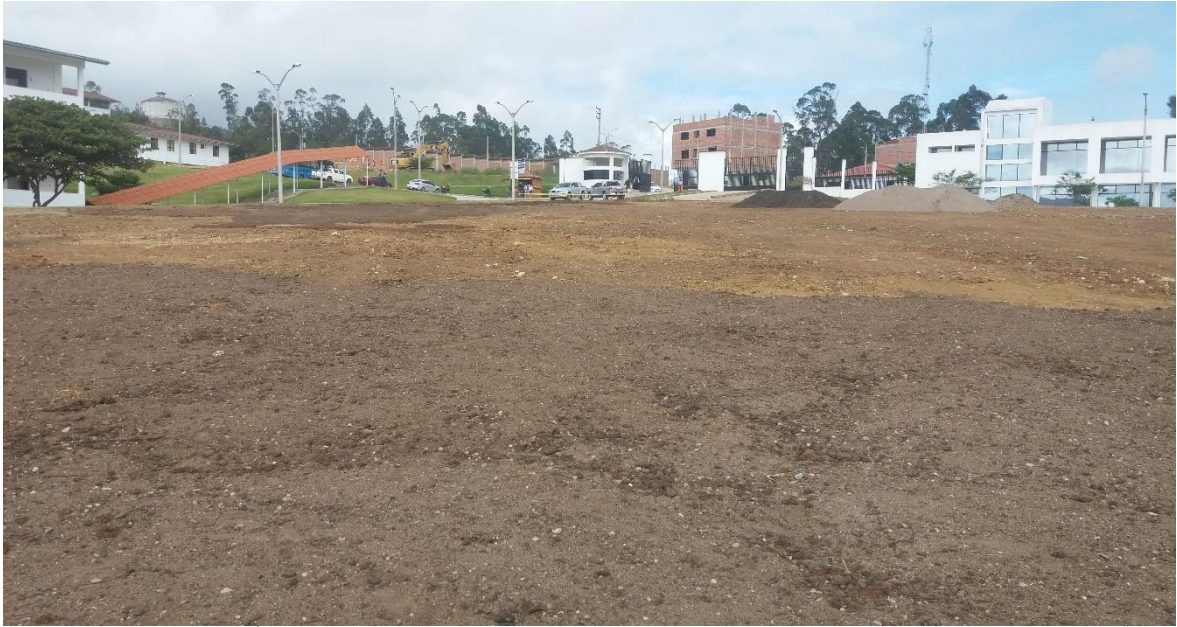
Fotografía 15: Área donde se enterraron Estructuras de drenaje pluvial.
