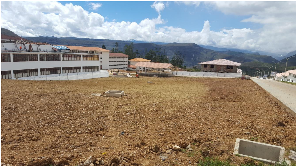
Fotografía 14: Estructuras de drenaje pluvial antes de ser enterradas.
