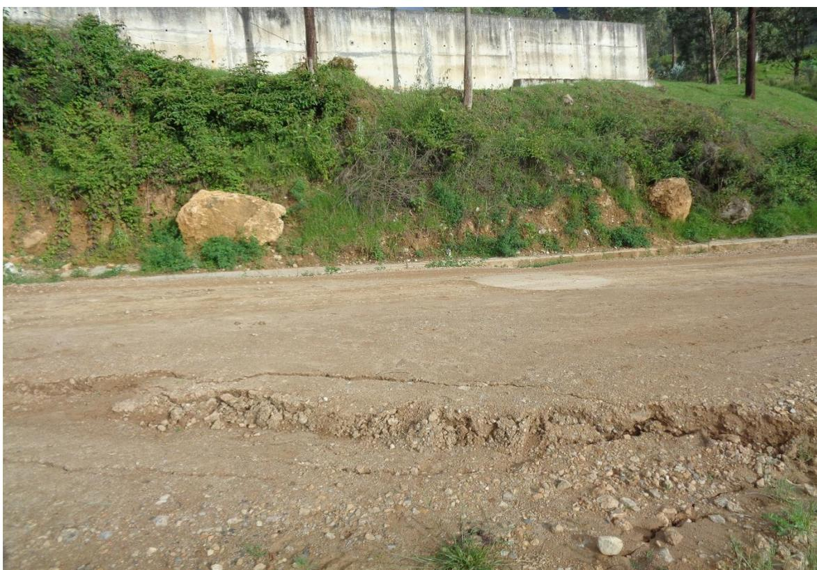
Foto N° 13. Deslizamiento existente en la parte inferior del ingreso principal a la Residencial Magisterial de la ciudad de Chachapoyas.
