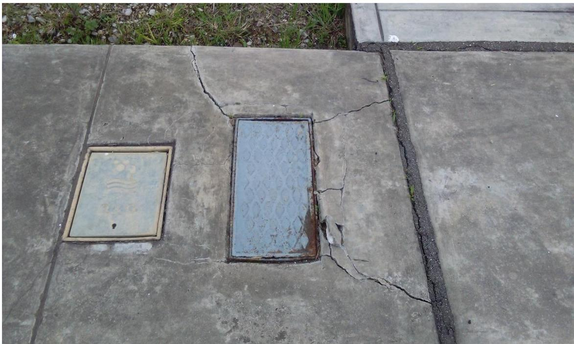
Foto N° 10. Fisuras en el pavimentado de las calles.
