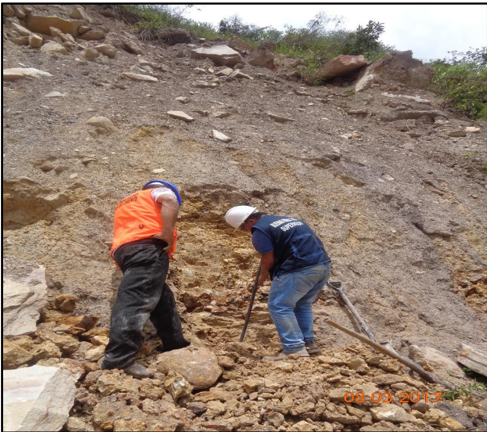
FOTO N° 10. Extracción del suelo C 03 tramo Km 07+500 – km 07+530
