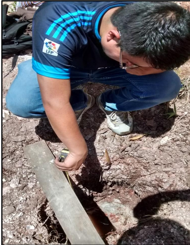
FOTO N° 29. Ensayo de permeabilidad km 07+500 – km 07+530
