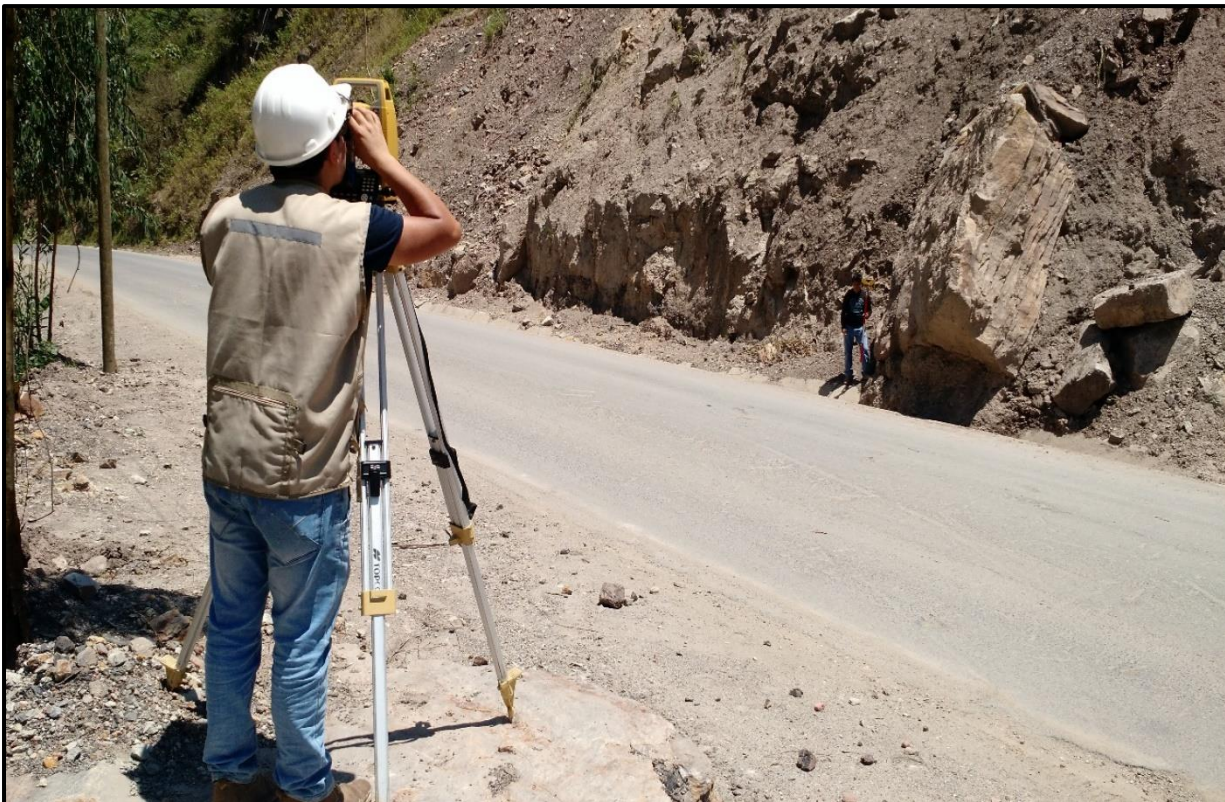
FOTO N°02. Levantamiento topográfico, tramo Km 07+500 – km 07+530
