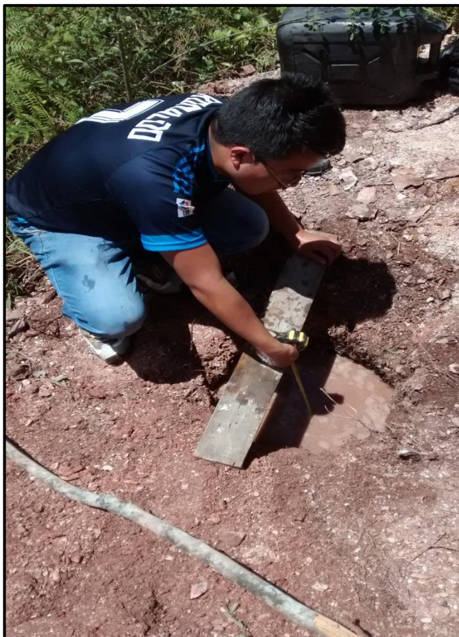
FOTO N° 30. Medición de la pérdida de agua km 07+500 – km 07+530
