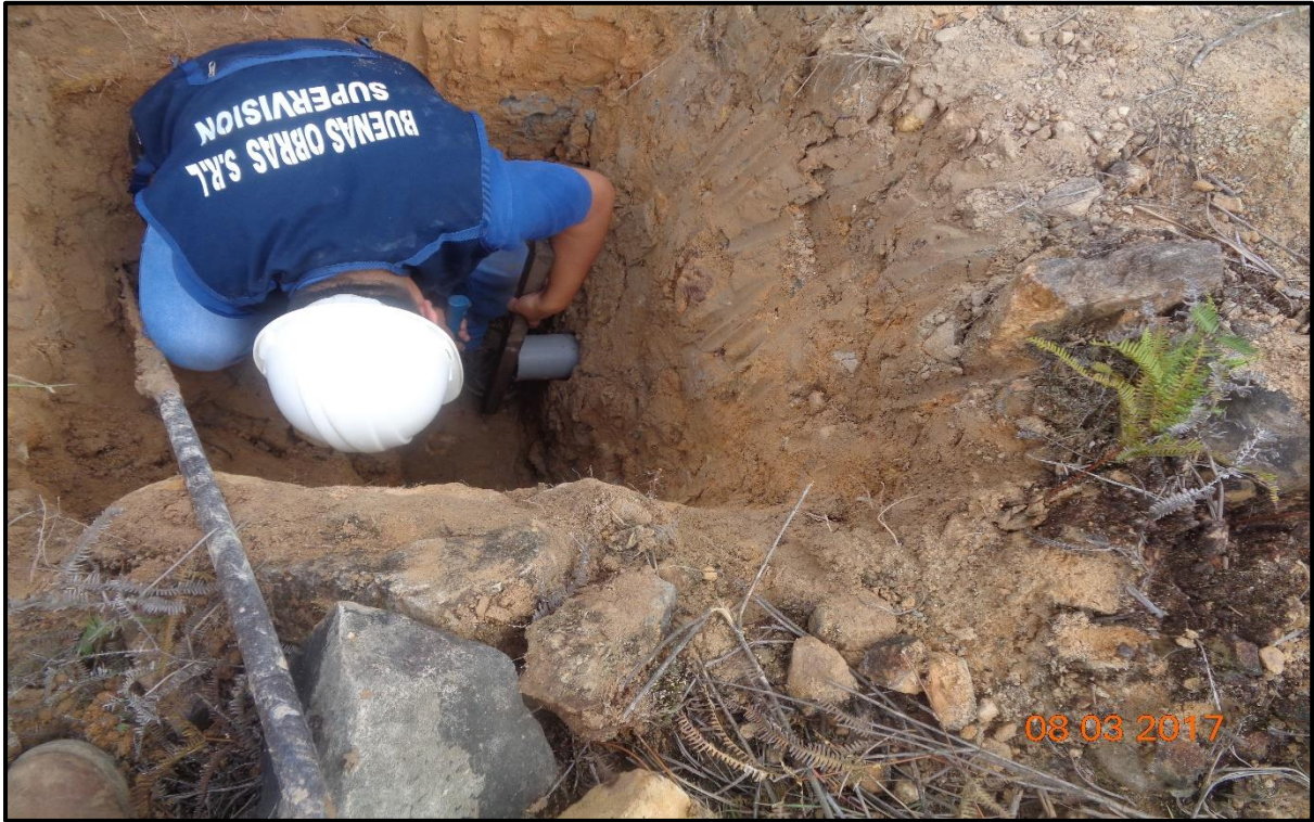
FOTO N°05. Extracción del primer estrato de la calicata N°01, tramo Km 07+300- km 07+320
