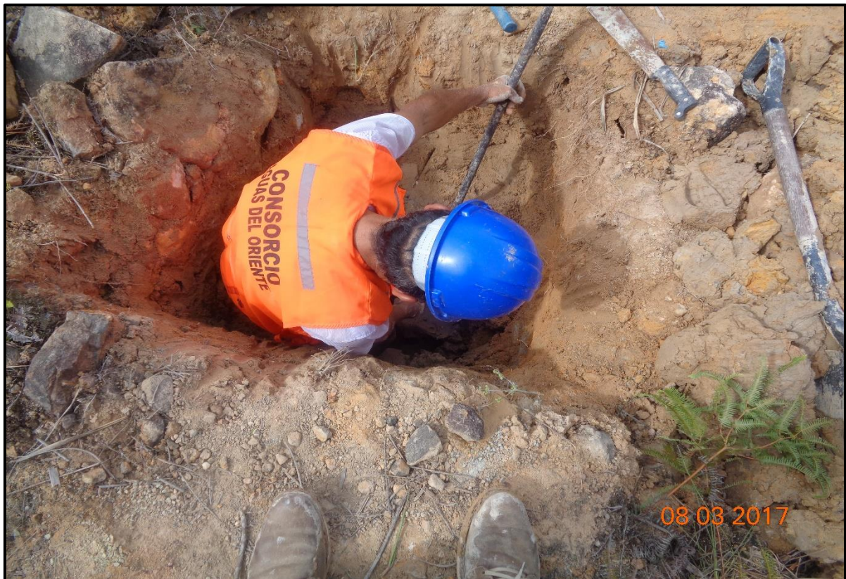
FOTO N°06. Excavación de la calicata N° 01, tramo Km 07+300 – km 07+320
