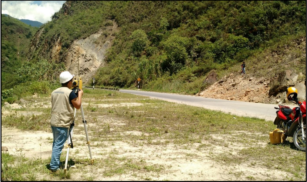
FOTO N° 01. Levantamiento topográfico, tramo Km 07+300 – km 07+320
