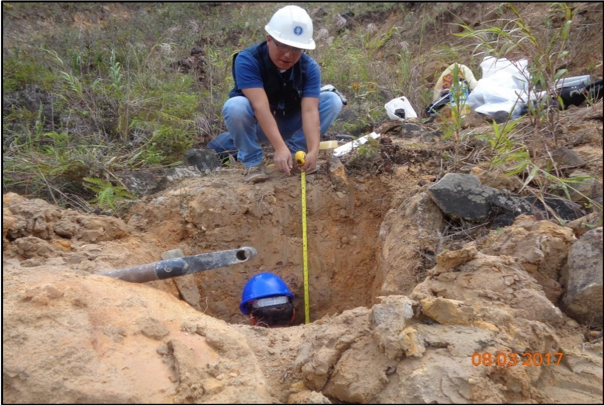
FOTO N°07. Medición de la calicata N° 01, tramo Km 07+300 – km 07+320
