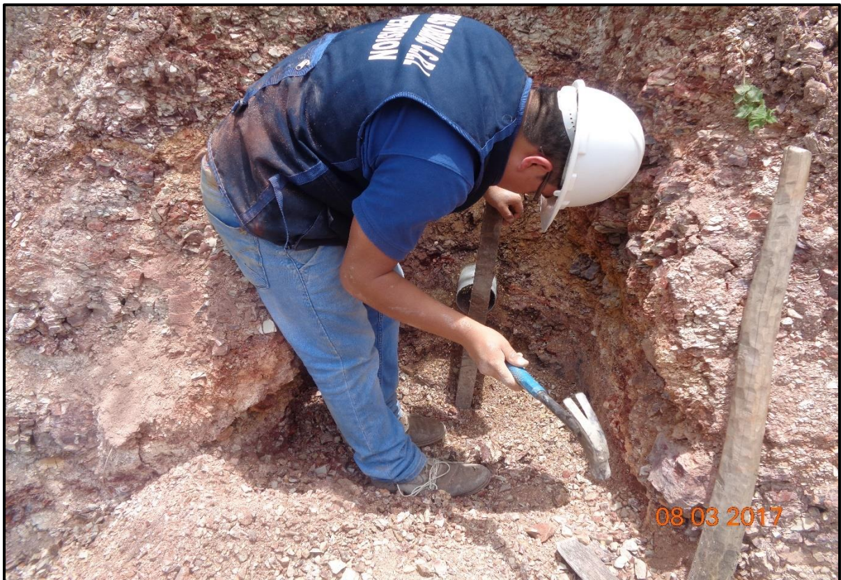
FOTO N°08. Extracción del suelo calicata N° 02, tramo Km 07+500 – km 07+530
