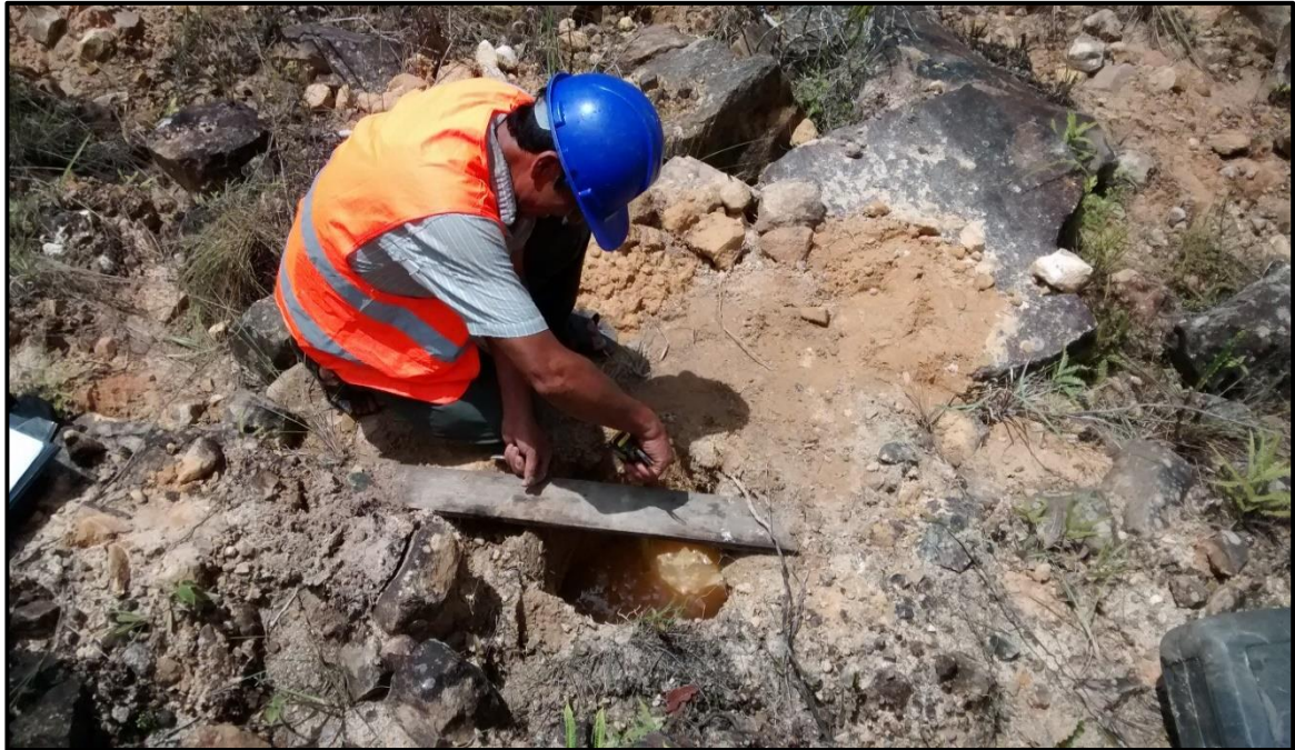
FOTO N° 27. Ensayo de permeabilidad km 07+300 – km 07+320
