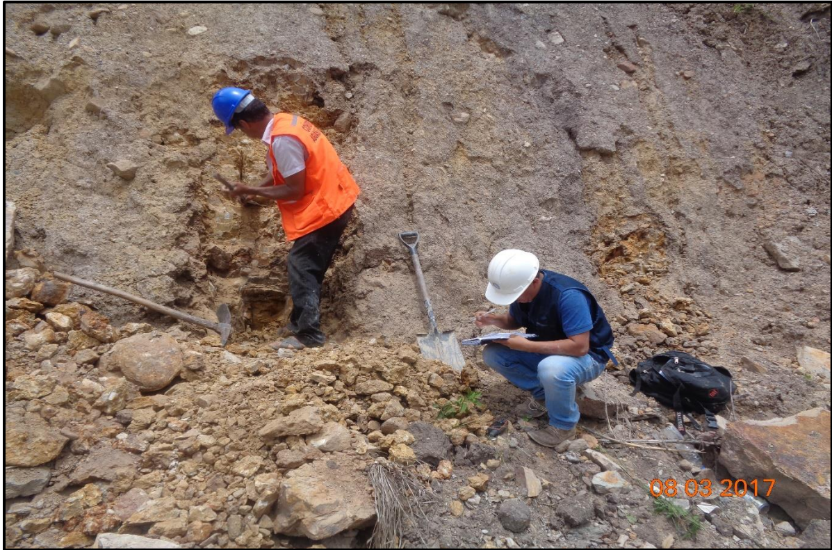
FOTO N° 11. Perfilado del tramo Km 07+500.
