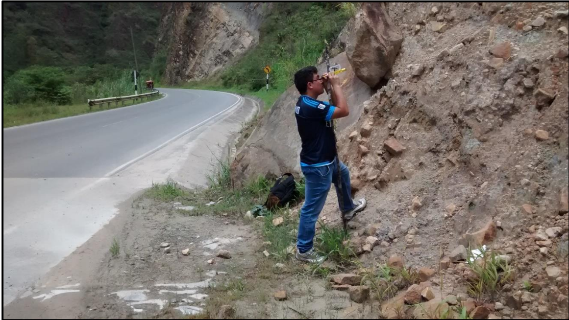
FOTO N°03. Obtención de la pendiente con eclímetro tramo Km 07+300 – km 07+320
