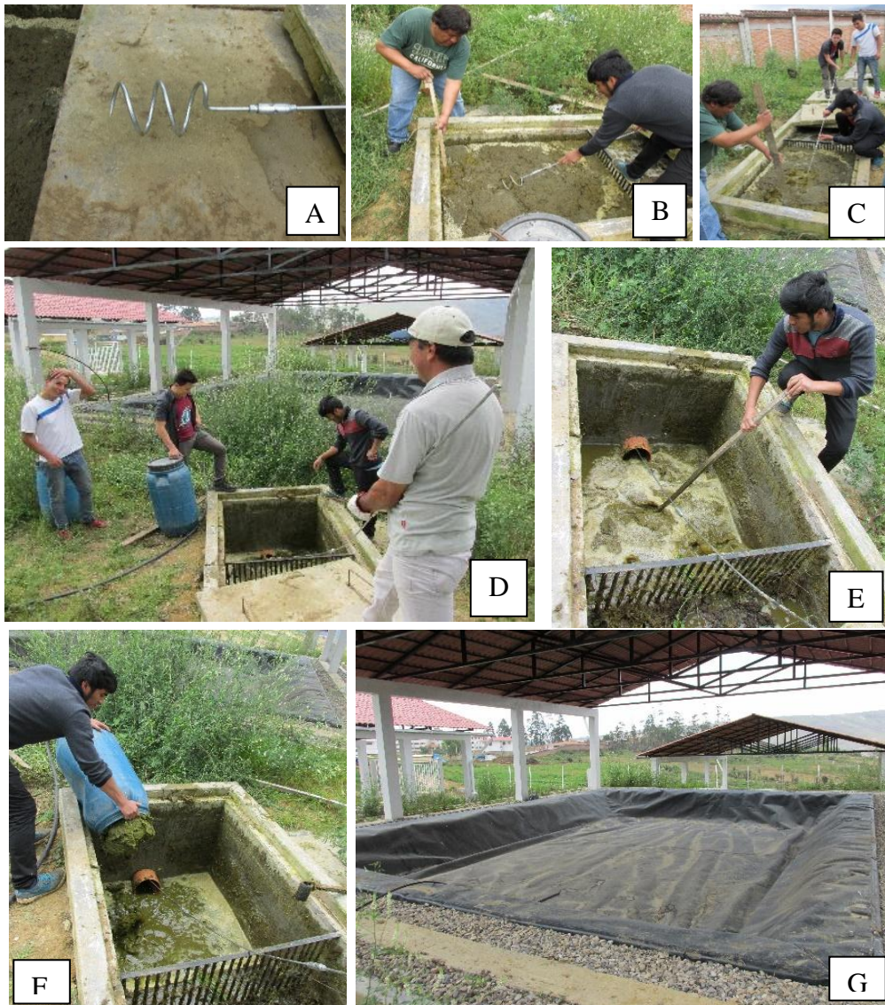
Figura 22. Desatoro de la tubería de alimentación del BTLC. A: punta de la sonda. B y C: sondeo de la tubería de alimentación. D y E: flujo de la alimentación al biodigestor. F: continuación de la inoculación con rumen. G: biodigestor en su volumen de trabajo.
