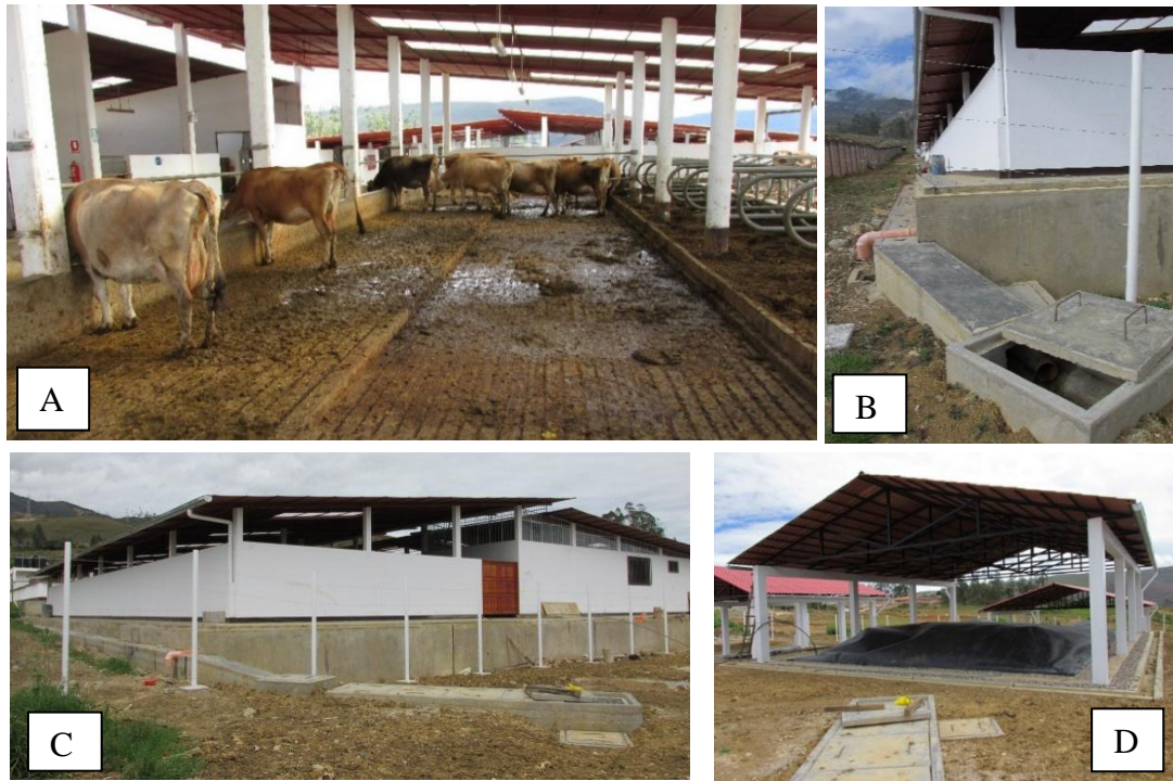
Figura 19. A: piso del establo de la UNTRM. B y C: canaleta de conducción de la mezcla estiércol:agua al sedimentador. D: sedimentador y biodigestor.
