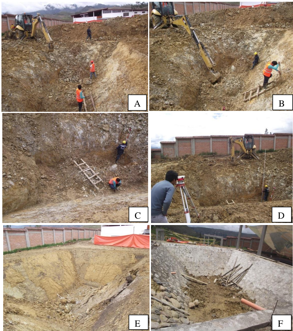
Figura 13. Construcción de la cámara del BTLC. A: excavación. B: terminado a palana. C: fijado de puntos para ubicar el fondo de la poza. D: verificación la profundidad de la poza. E: derrumbes en paredes por lluvias. F: reforzado de paredes con canto rodado concreto.
