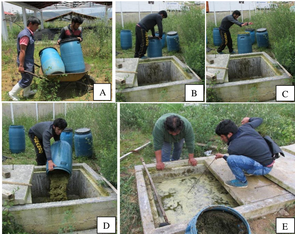
Figura 21. Inoculación con rumen en el BTLC. A: transporte del rumen. B, C y D: carga del rumen. E: ingreso de la mezcla rumen: agua al biodigestor.
