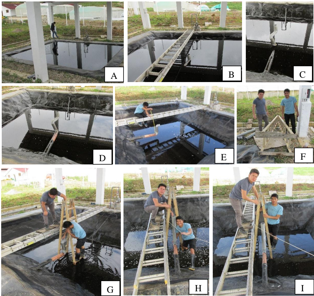
Figura 31. A, B, C, D y E: evacuación de la laguna de biol. F, G, H e I: cambio de tubos para subir el nivel de rebose del biodigestor hacia esta laguna.
