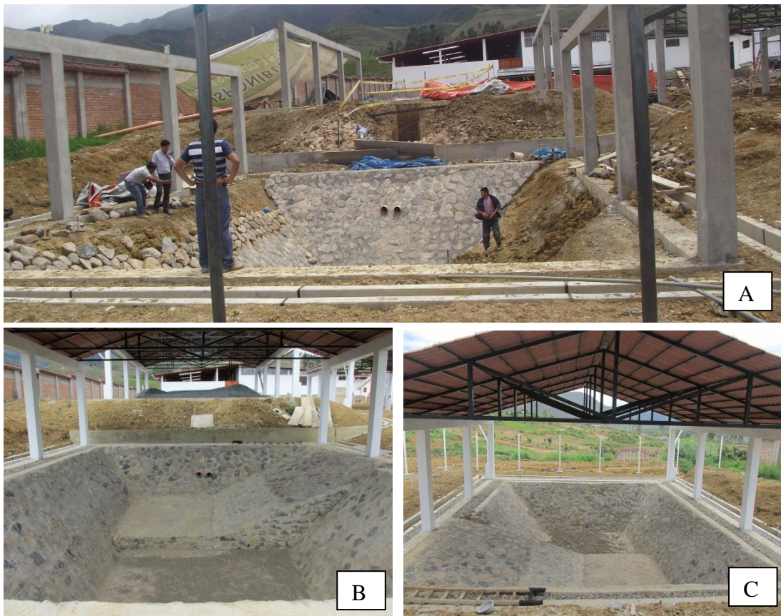
Figura 17. Cámara para secado de lodos de fondo del digestor. A: reforzado de paredes con canto rodado y concreto. B: rampa de acceso al fondo de la cámara. C: cámara terminada.
