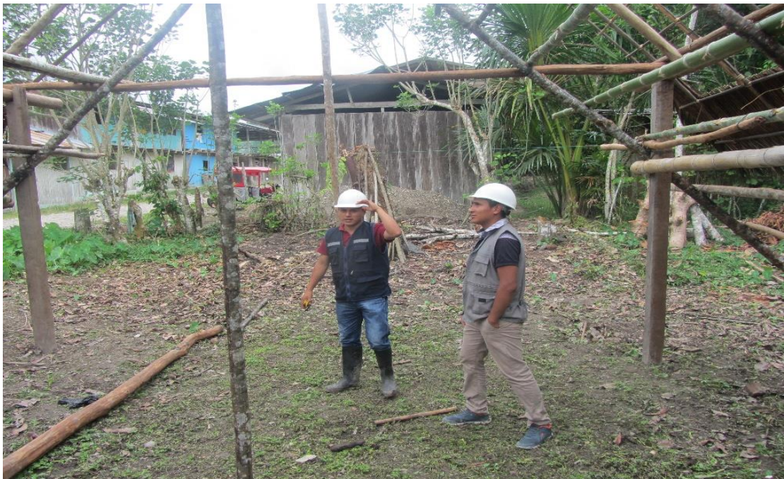
Foto N° 6: Investigadores verificando estructura de madera para la cubierta.
