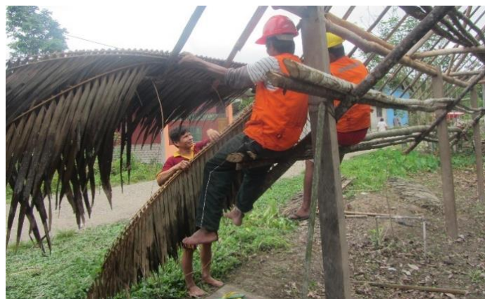
Figura 44. Colocación de hojas de yarina.
