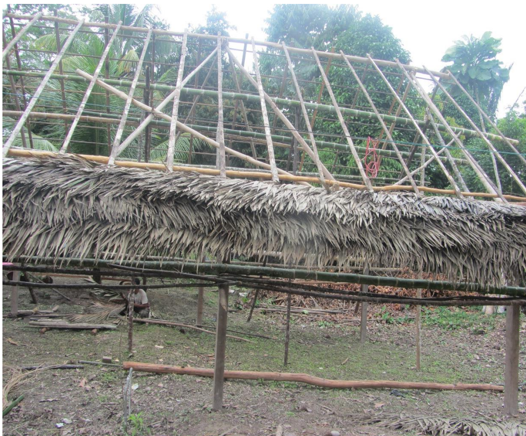
Foto N° 8: Vista exterior de cubierta de yarina. .
