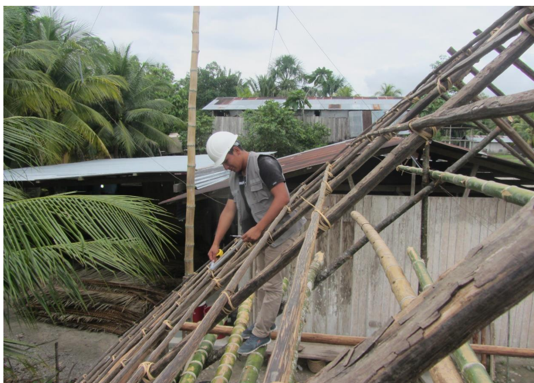
Foto N° 20: Toma de datos en distribución de correas y viguetas.
