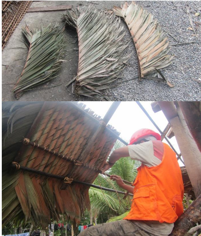
Figura 34. Selección por tamaño y amarrado de la primera fila de palmiche.
