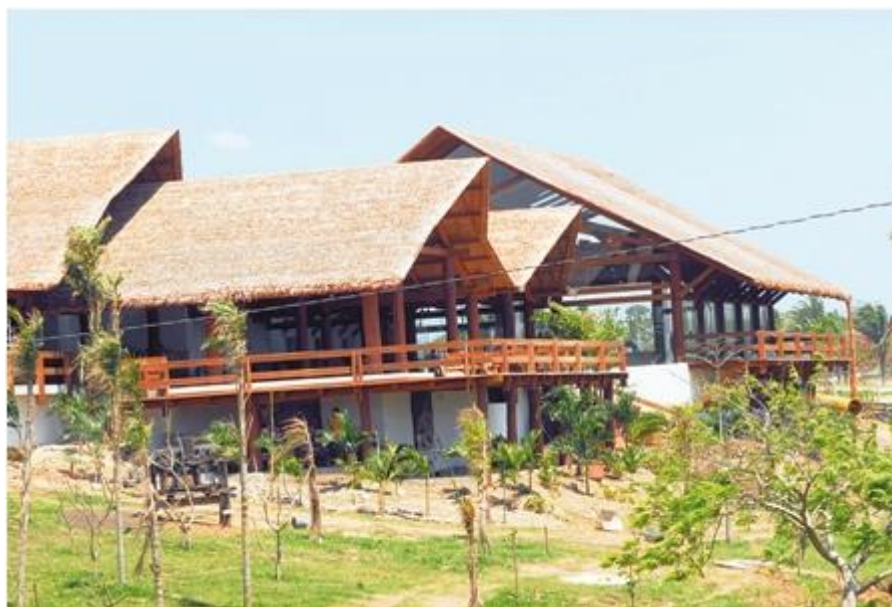
Figura 1. Techos con estilo rústicos construido con hojas de palmiche.
