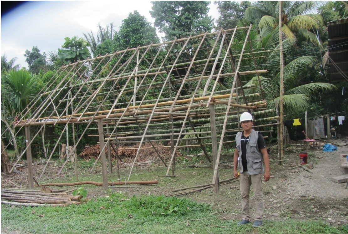
Foto N° 5: Instalación de correa y viguetas para cubierta de yarina.
