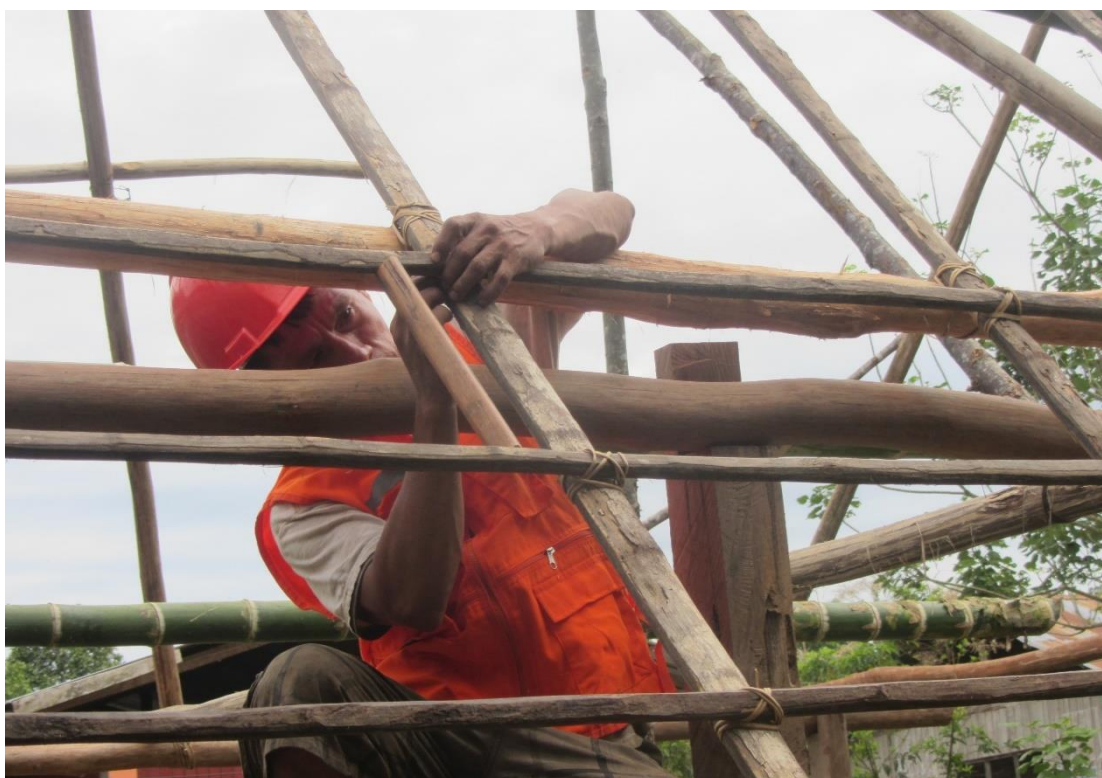
Foto N° 16: Operario realizando amarre de correas.
