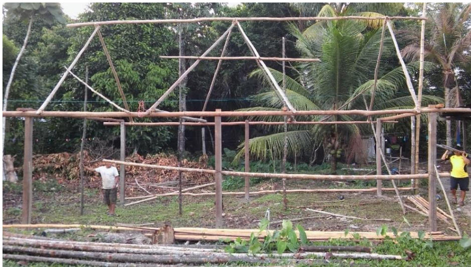
Figura 27. Estructura de madera para techo.
