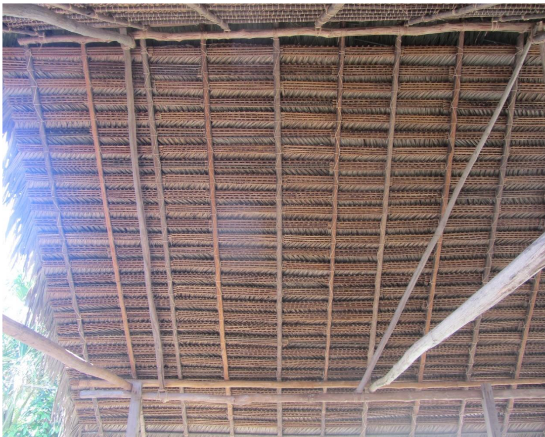
Foto N° 9: Vista interior de cubierta de yarina.
