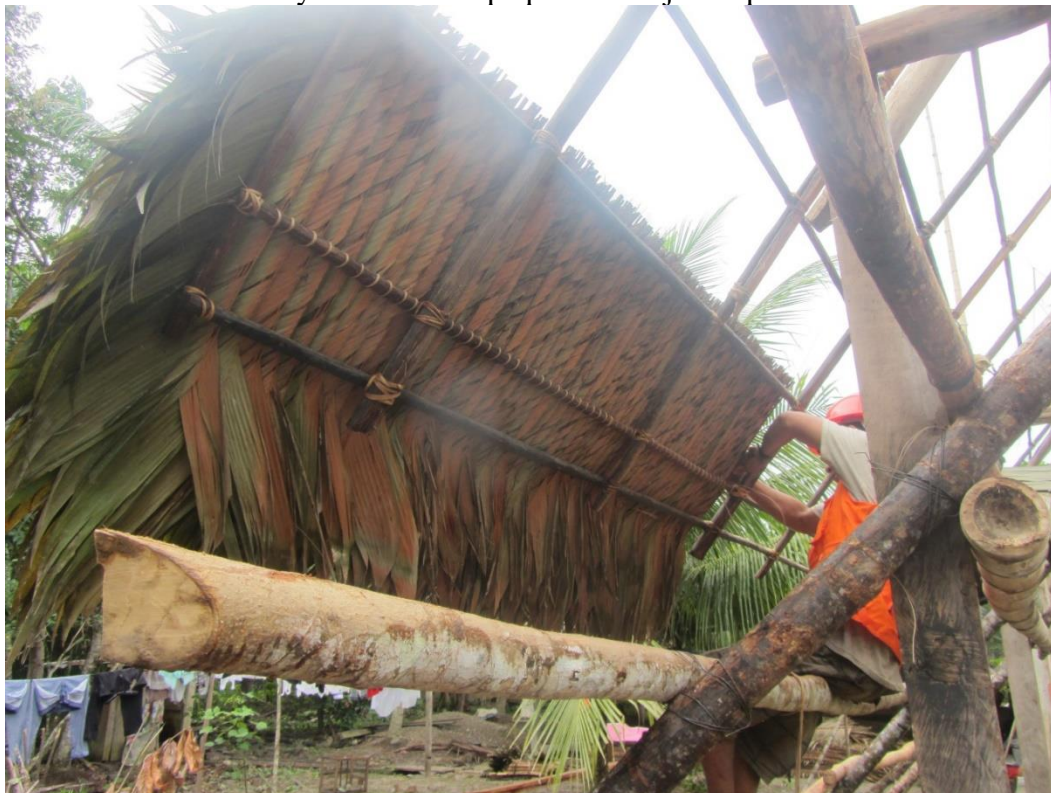
Foto N° 18: Colocado y amarrado de paquete de hojas de palmiche en cubierta.
