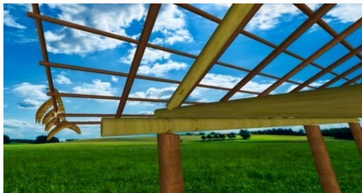
Figura 36. Colocado de primera hoja de palmiche.
