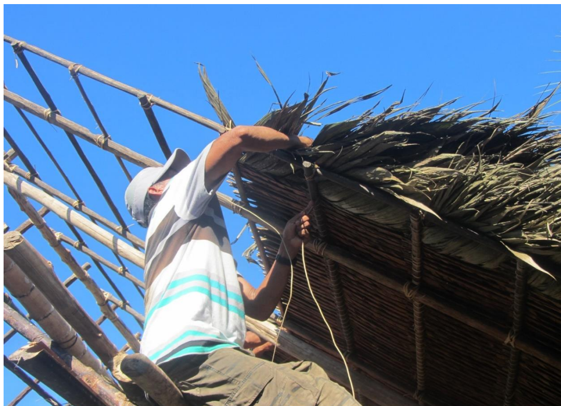
Foto N° 19: Operario colocando y amarrando paquetes de hojas de palmiche al final de la fila.
