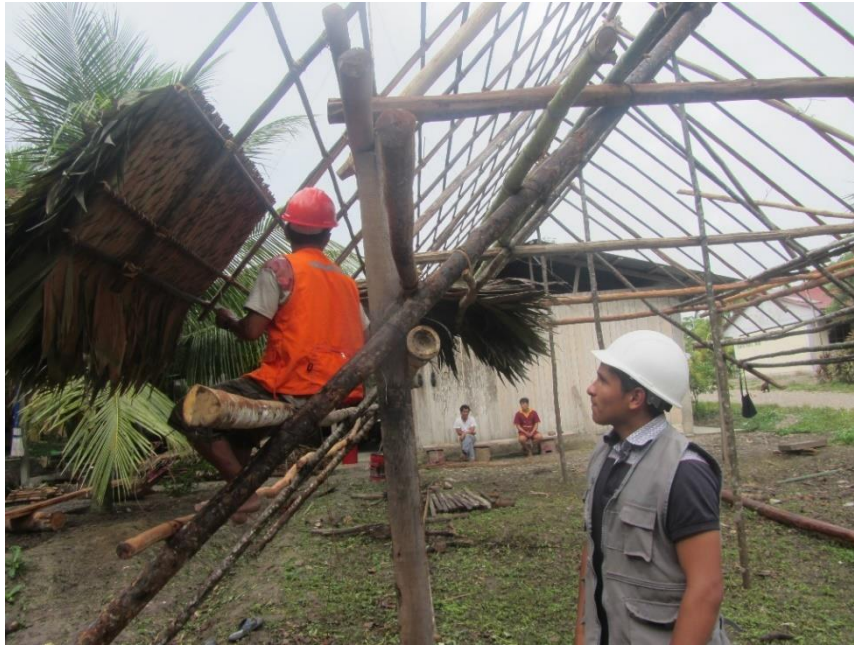
Figura 30. Posición adecuada para desarrollar trabajos de amarrado.
