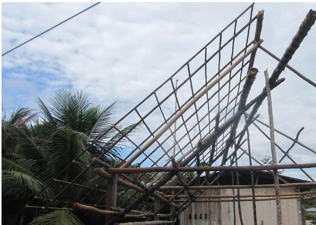
Foto N° 17: Instalación de correas y viguetas.
