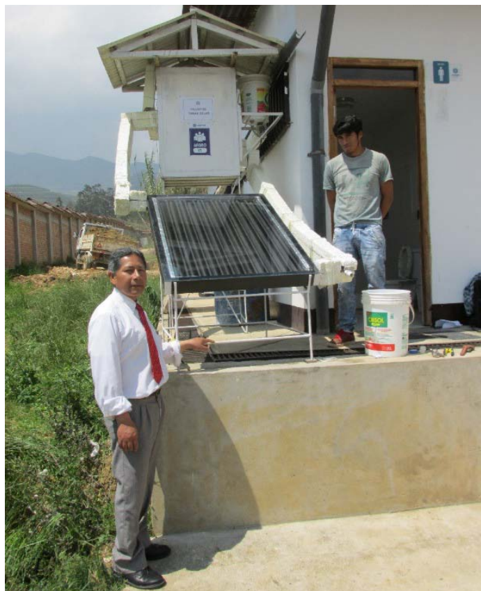
Fotografía 11. Ubicación del colector solar en la zona de pruebas.
