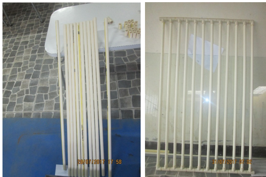
Fotografía 5. Corte y ensamblaje de los 12 tubos verticales de PVC con tes y codos.
