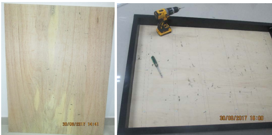
Fotografía 2. Revestimiento de la base con triplay.
