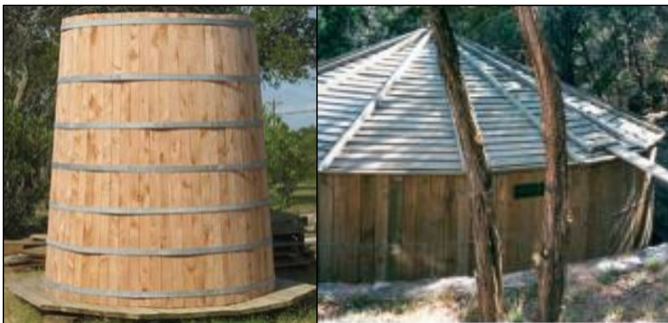
Figura 3. Tanques de almacenamiento de agua contruidos a base de madera.
