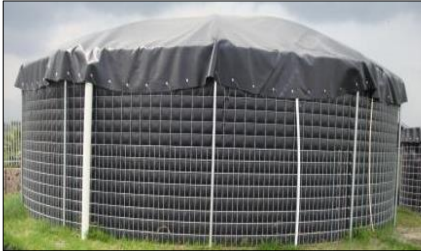
Figura 4. Tanque construido con armazón de malla metálica y recubierta con geomembrana
