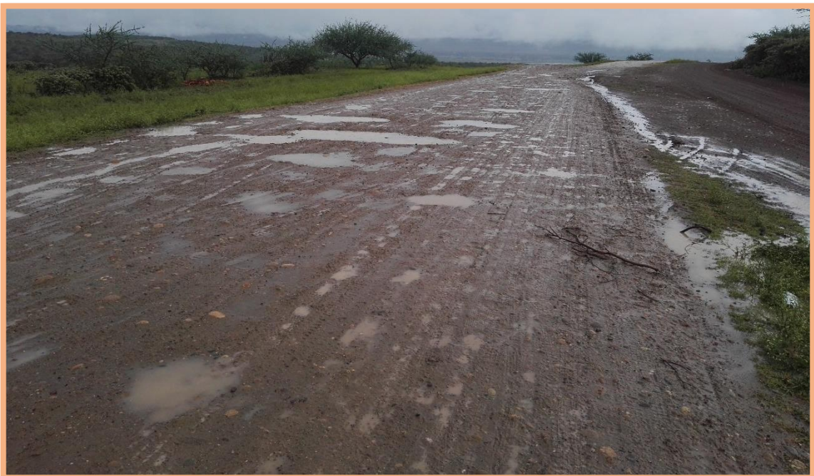
Figura 121: Unidad de Muestra N°3 (1.130km-1.185km). Falla 82 (Drenaje Inadecuado), según Tabla 9, se caracteriza de mediana severidad (Nivel M), por tener vegetación y pozos de agua, su longitud es la máxima de 110 m.
