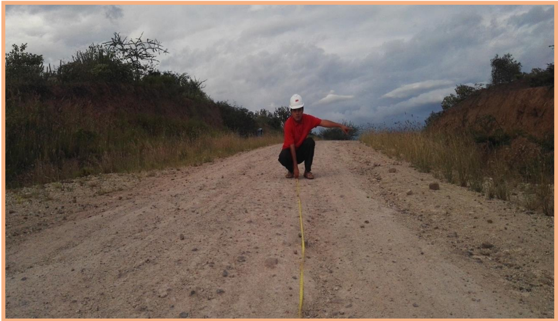
Figura 136: Unidad de Muestra N°6 (2.640km-2.690km). Inicio de la Unidad de Muestra N°6, midiendo la longitud de 50m respectivo, considerando el ancho de la calzada de 6.50m (Figura 79), cumple con el área estipula en la técnica de 320.0 m 2
