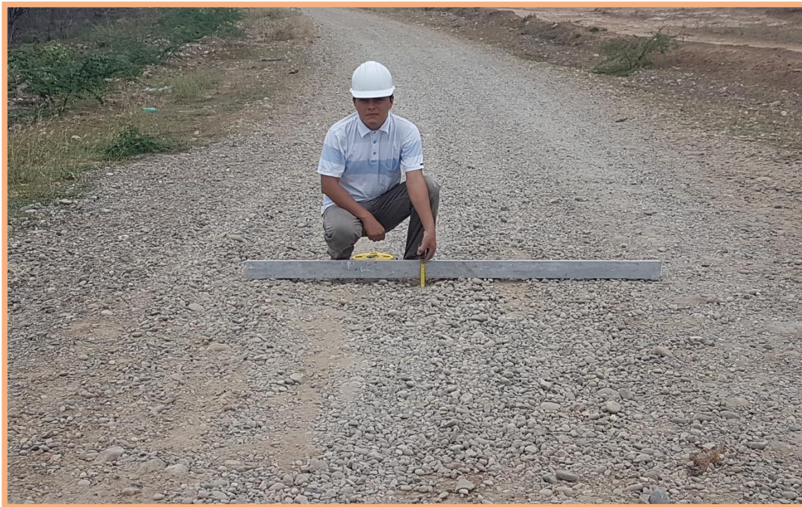
Figura 72: Sección N°4 (1.5-2km). Falla de deformación (ahuellamiento), desde 1.50km hasta 1.753km (253m de extensión), según Tabla 2 es de gravedad 1 ( h < 5\text{cm} ) y con ancho de 5.50m por ser mínimo en toda la plataforma.
