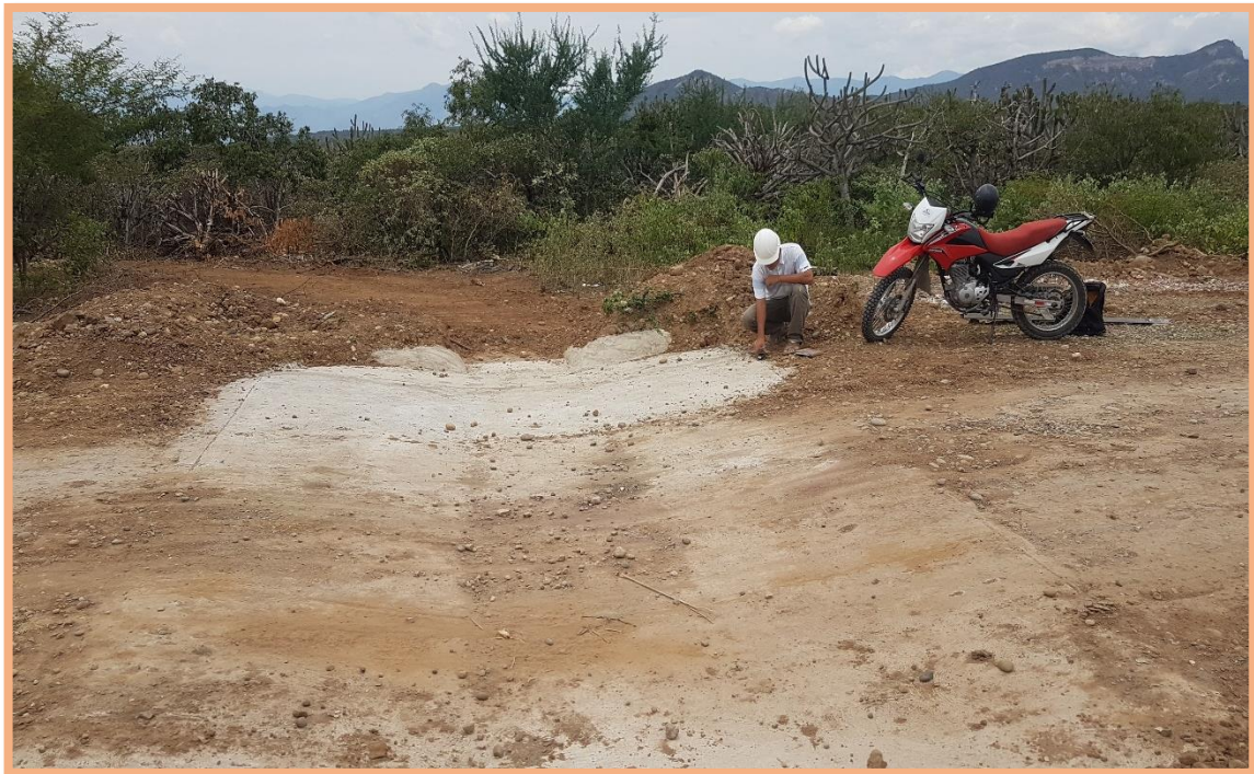
Figura 79: Sección N°6 (2.5-3km). En el 2.590km se halló un badén para evacuar aguas.
