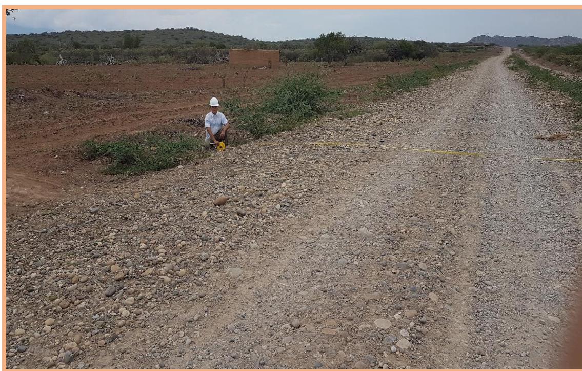
Figura 67: Sección N°3 (1-1.5km). Medición del ancho de la calzada, dando 5.50m de longitud.
