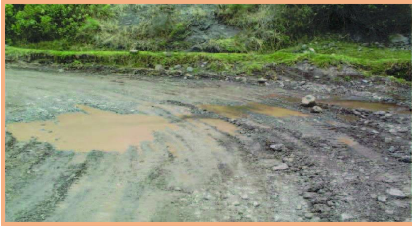
Figura 11: Lodazal. Se percibe el estancamiento de aguas, debido a los baches y deformación de la vía.
