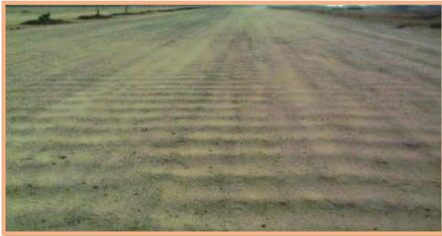
Figura 10: Encalaminado, Gravedad 1: Sensible al usuario, pero profundidad < 5 cm.
