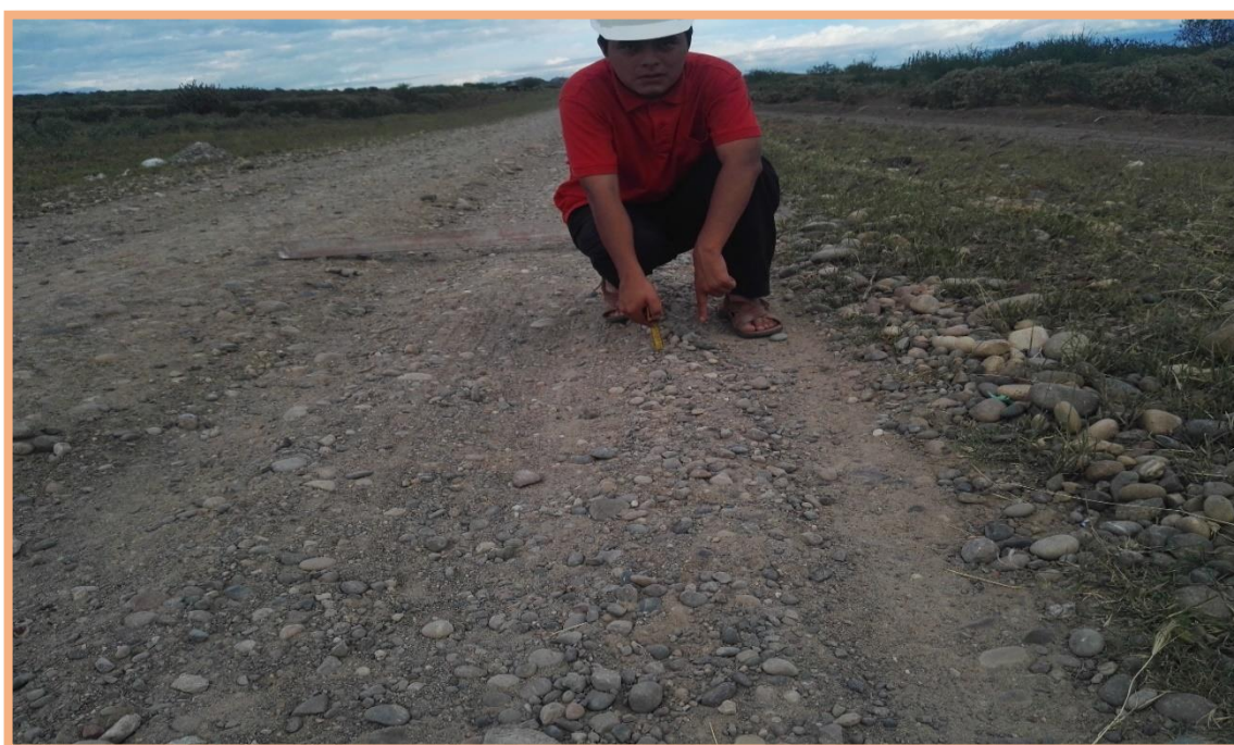
Figura 129: Unidad de Muestra N°4 (1.321km-1.376km). Falla 87 (Agregado suelto), según Tabla 9, la altura <math><5\text{cm}</math>, por lo que es de severidad baja (Nivel L). Su longitud es la máxima de 110m.
