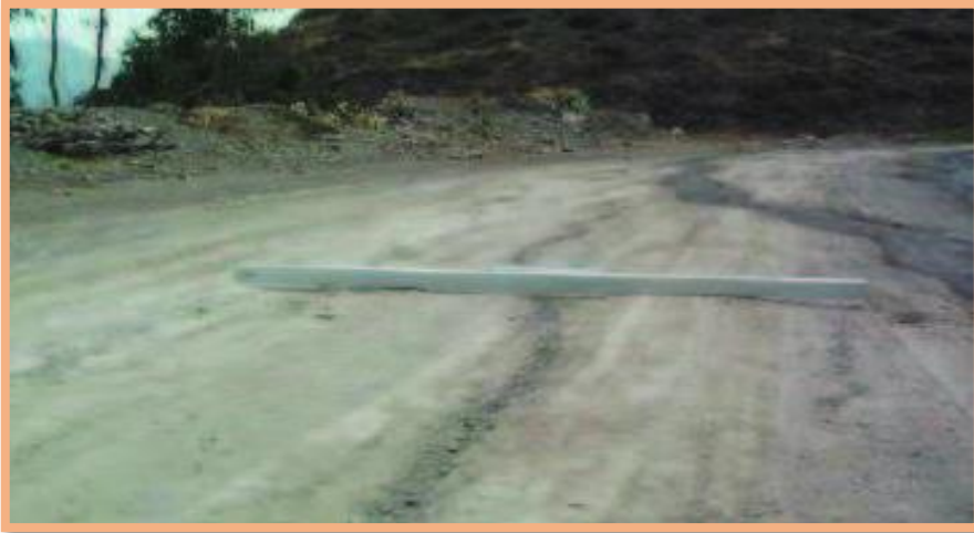
Figura 4: Erosión, Gravedad 1: Sensible al usuario, pero < 5 cm Se percibe una erosión leve, utilizando como medición un escalímetro y una regla.
