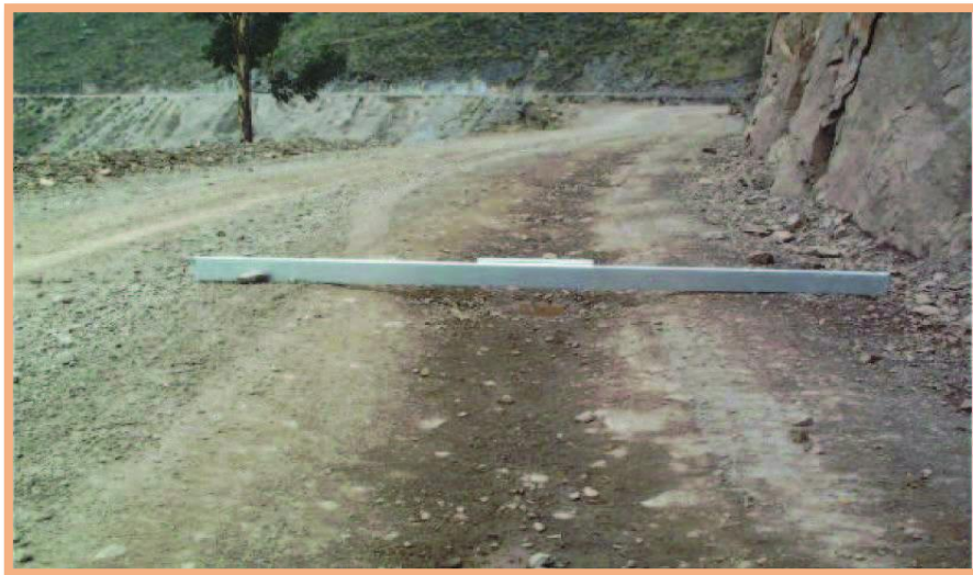
Figura 3: Deformación, Gravedad 3: Huella/ hundimiento mayor a 10 cm. Se percibe una gran deformación notoria, utilizando como medición un escalímetro y una regla.
