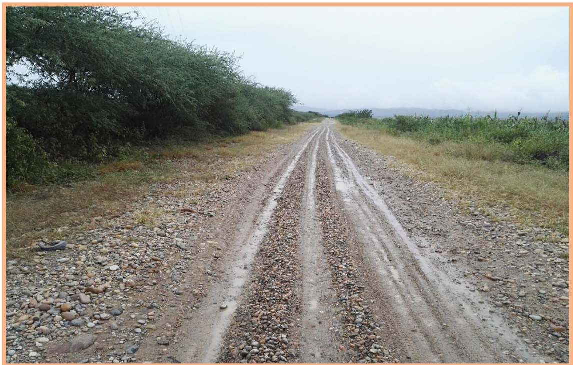
Figura 94: Sección N°7 (3-3.5km). Falla de deformación, se presentó a partir del 3.11km hasta 3.50km, según la Tabla 2 especifica que es de gravedad 1, huellas menores de 5 cm.
