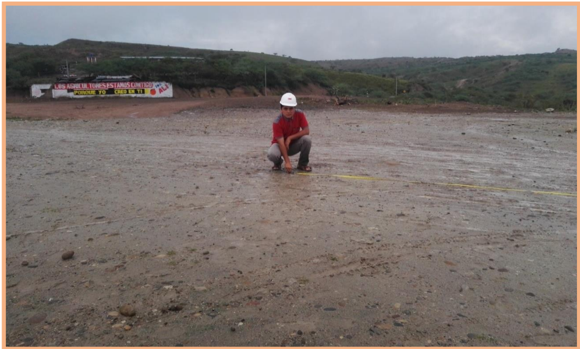
Figura 104: Unidad de Muestra N°1 (202-257m). Inicio de la Unidad de Muestra N°1, midiendo la longitud de 55m respectivo, considerando el ancho de la calzada de 5.50m (Figura 48), cumple con el área estipula en la técnica de 302.5 m 2 .
