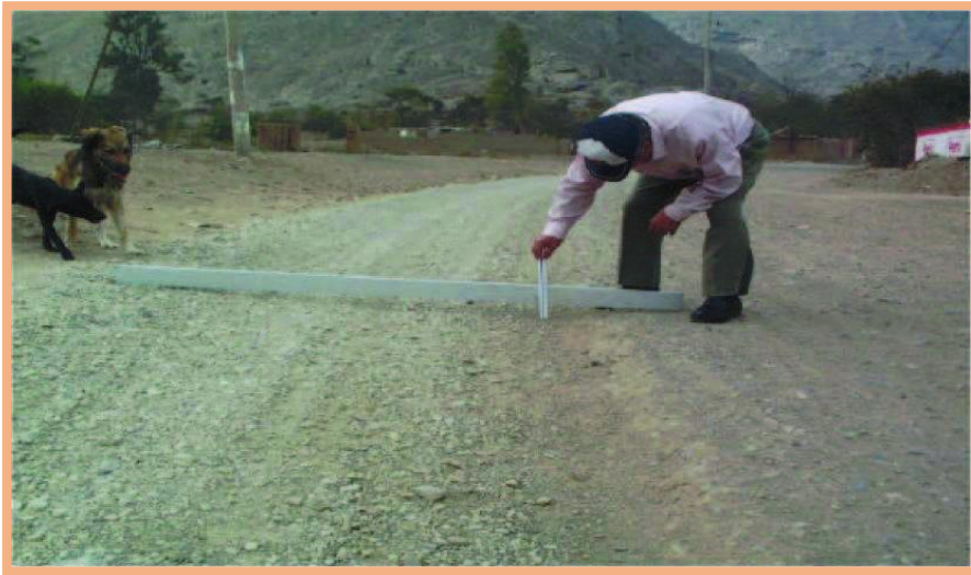
Figura 2: Deformación, Gravedad 2: Huella/ hundimiento entre 5cm y 10 cm. Se observa la medición respectiva de la falla utilizando un escalímetro y una regla.
