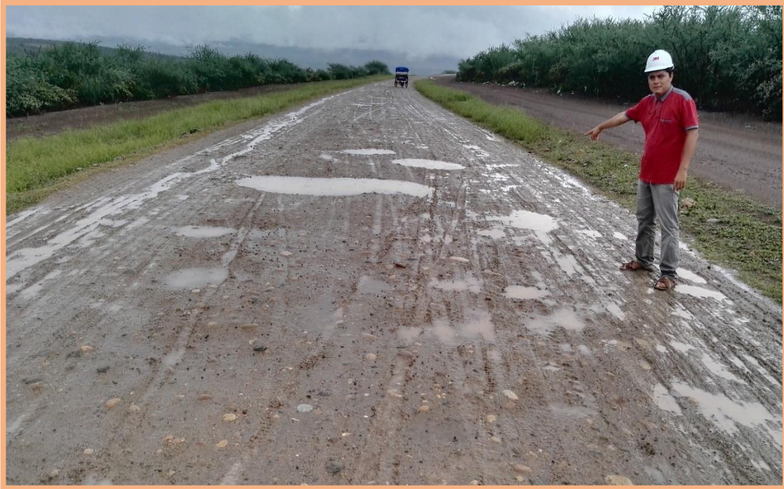
Figura 65: Sección N°3 (1-1.5km). Falla de baches y deformación, encontrado en el 1.045km, según Tabla2, menciona que este tipo de bache es de gravedad 3, necesita una reconstrucción. Además, existe deformación mínima (<5cm) en todo el ancho de plataforma.
