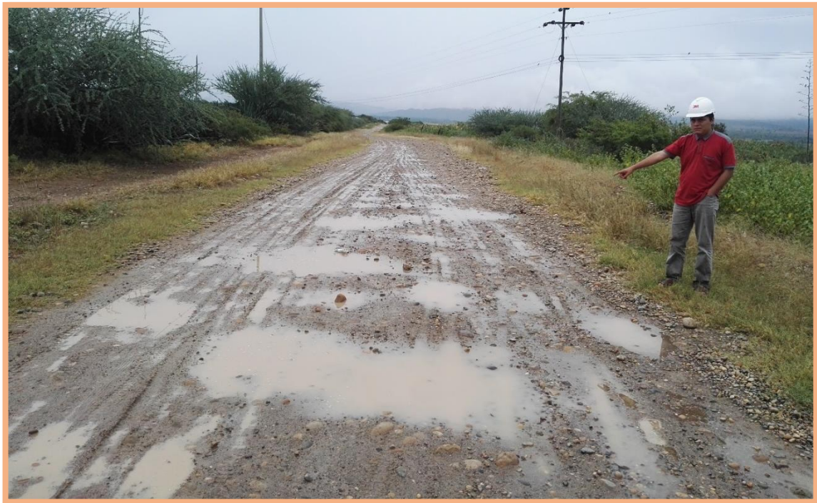
Figura 93: Sección N°7 (3-3.5km). Falla de bache y deformación, se presentó en el 3.39km, según la Tabla2 especifica que es de gravedad 3, necesita una reconstrucción. Además, existe deformación mínima (<5cm) en todo el ancho de plataforma.
