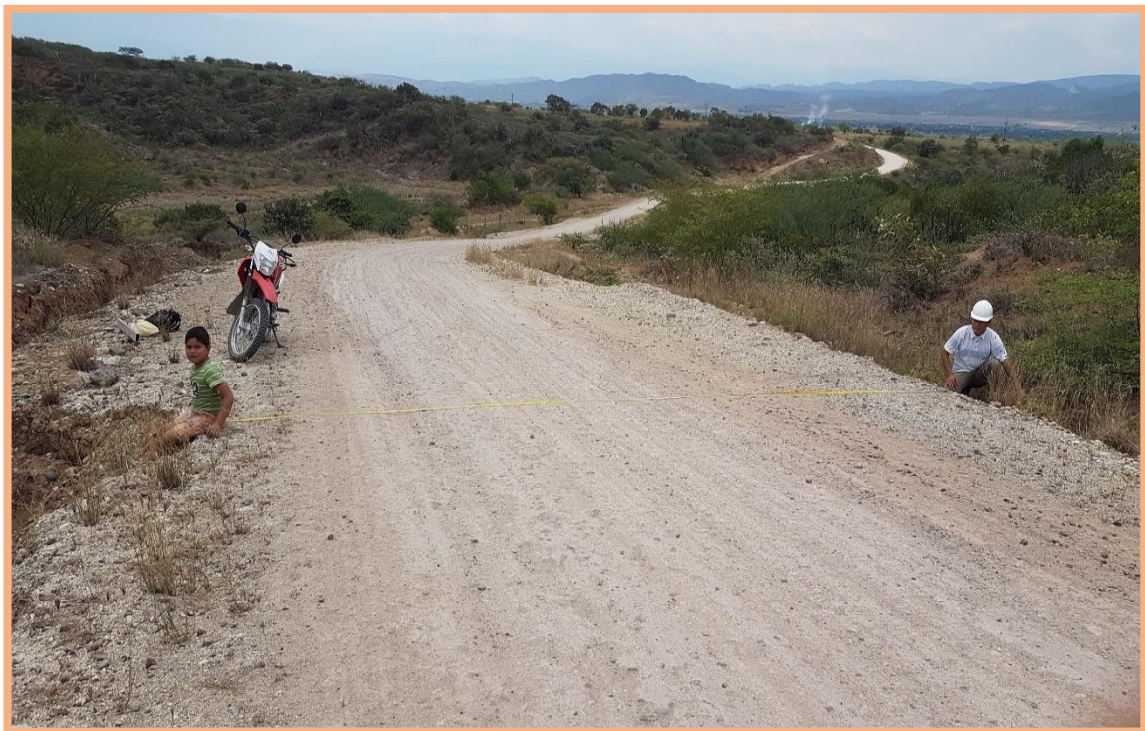
Figura 80: Sección N°6 (2.5-3km). Medición del ancho de la calzada, dando 6.50m de longitud.
