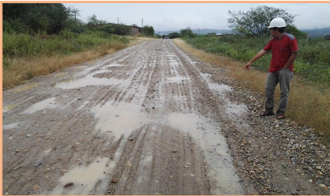
Figura 102: Sección N°8 (3.5-3.7km). Falla de bache y deformación, se presentó en el 3.67km, según la Tabla 2 específica para baches que es de gravedad 3, necesita una reconstrucción. Deformación en todo el ancho de plataforma, de gravedad 1, sensible al usuario <5cm.
