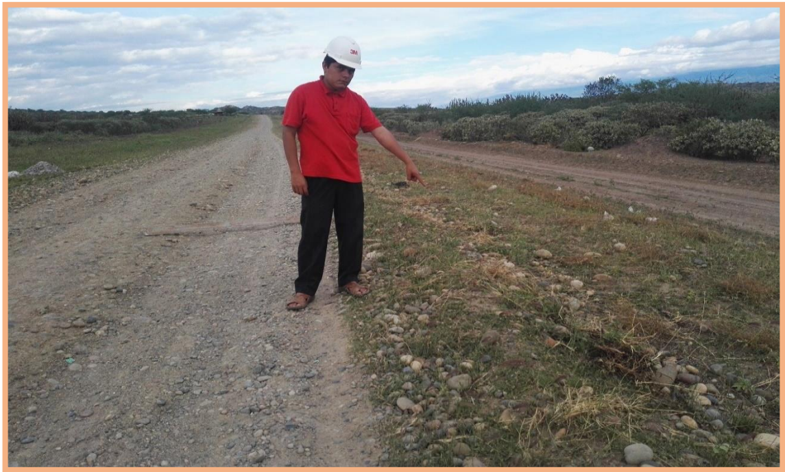
Figura 126: Unidad de Muestra N°4 (1.321km-1.376km). Falla 82 (Drenaje inadecuado), según Tabla 9, es de baja severidad (Nivel L), por presentar vegetación y desechos.
