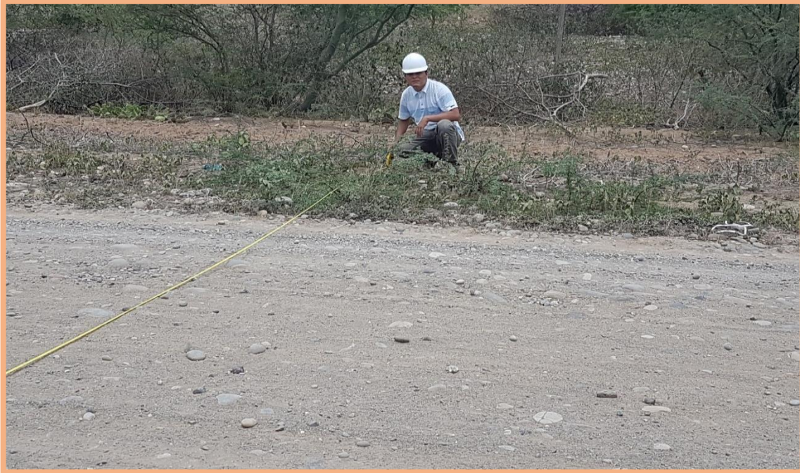
Figura 95: Sección N°8 (3.5-3.7km). Medición del ancho de la calzada, dando 6.00m de longitud.
