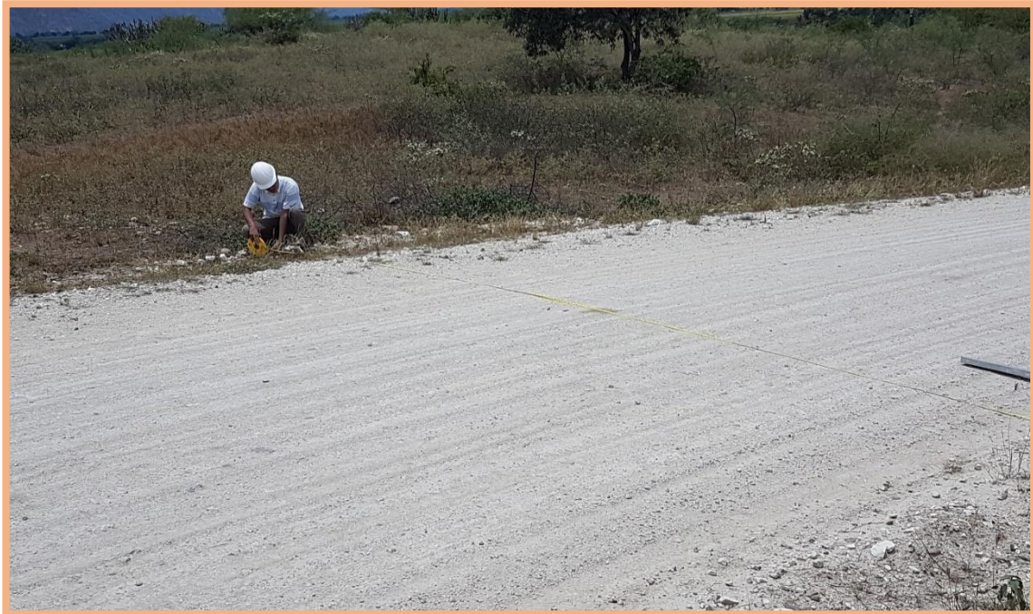
Figura 85: Sección N°7 (3-3.5km). Medición del ancho de la calzada, dando 6.00m de longitud.
