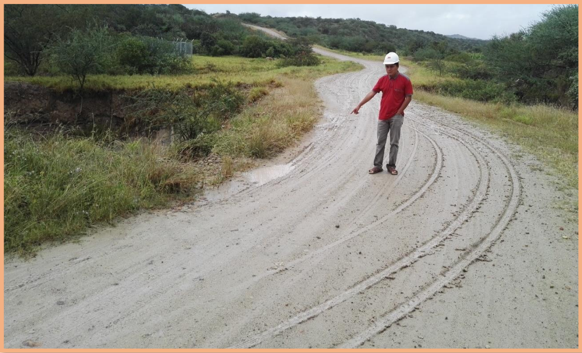
Figura 83: Sección N°6 (2.5-3km). Falla de bache, se presentó en el 2.910km, según la Tabla 2 especifica que es de gravedad 2, necesita una capa de material adicional.
