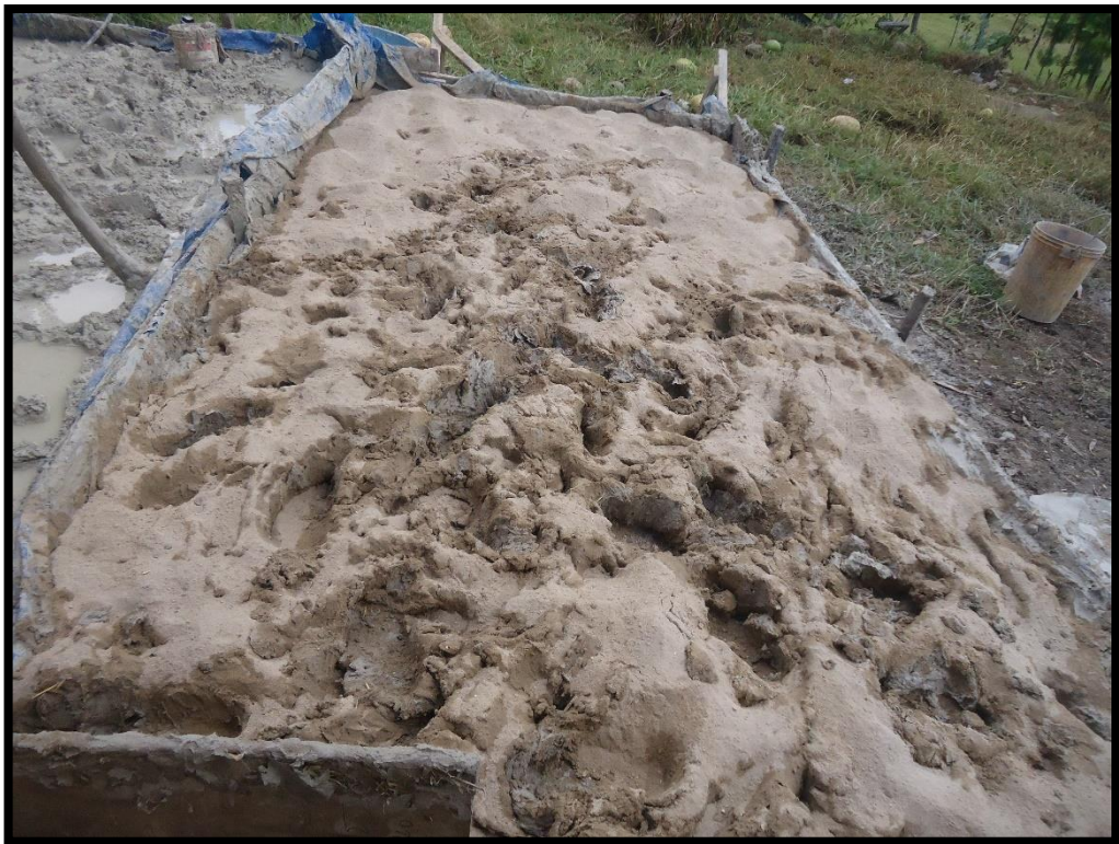
Figura 10. Mezclado de barro, paja, arena y ceniza (adobe con adición de ceniza y arena).
