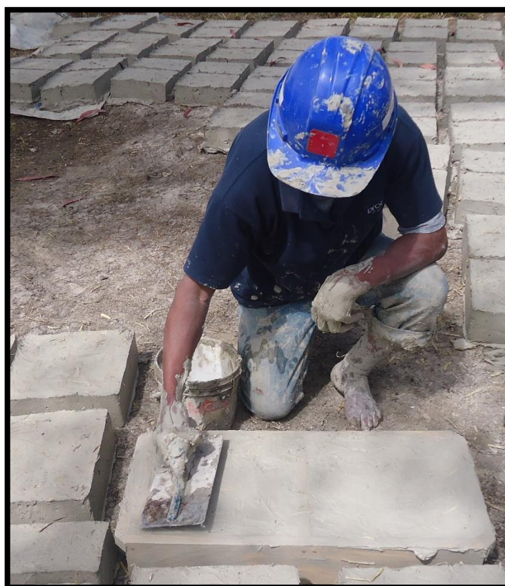
Figura 12. Colocación de la mezcla en la adobera.
