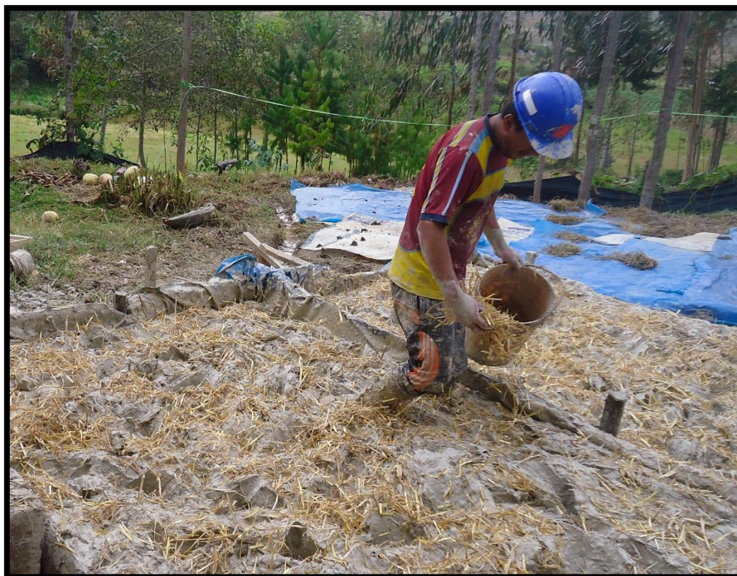
Figura 11. Mezclado de barro y paja (adobe convencional).
