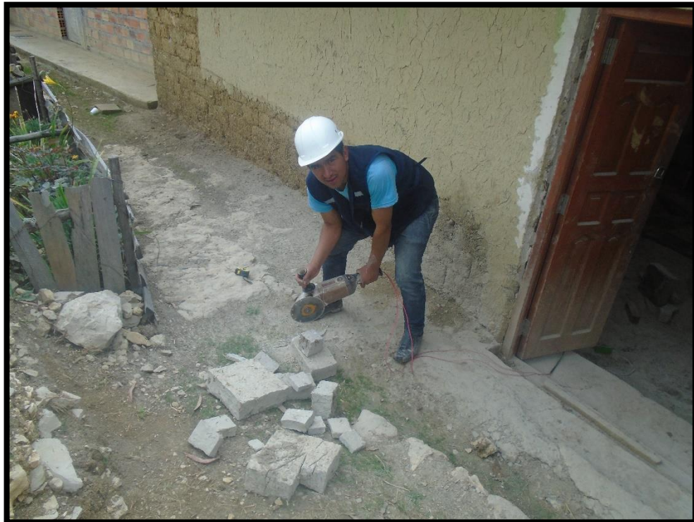
Figura 14. Cortado de cubos para el ensayo de resistencia a compresión.
