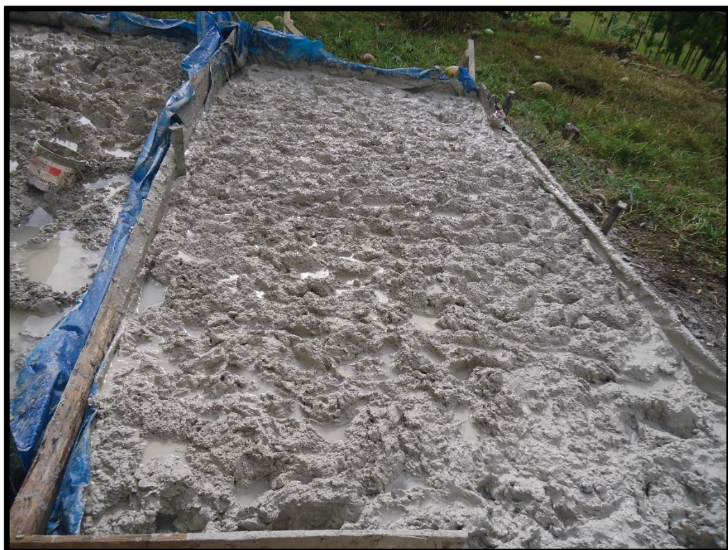
Figura 8. Preparación del barro (mezcla suelo – agua).
