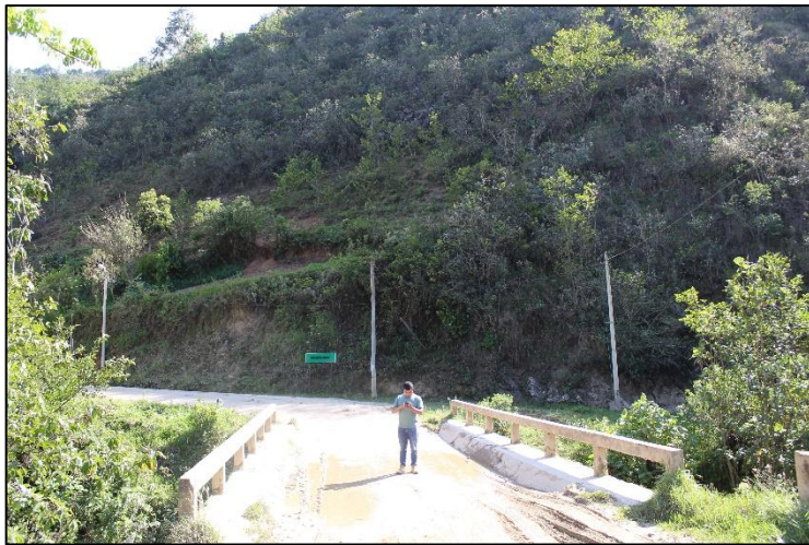
Fotografía 30. Punto de control terrestre en el puente de Choctamal.
