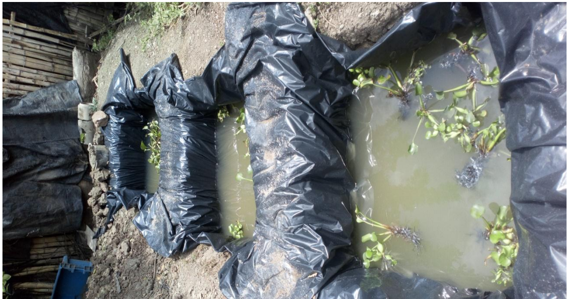
Figura 9. Instalación de los estanques con Jacinto acuático
