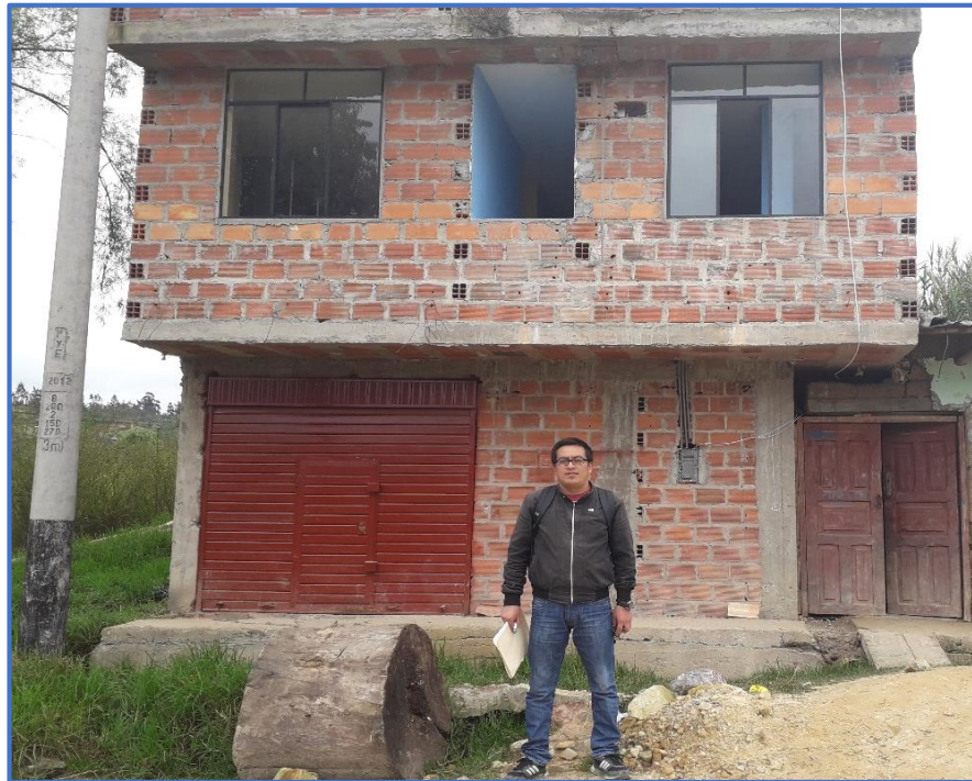
Imagen N° 01. Sistema de construcción albañilería confinada
