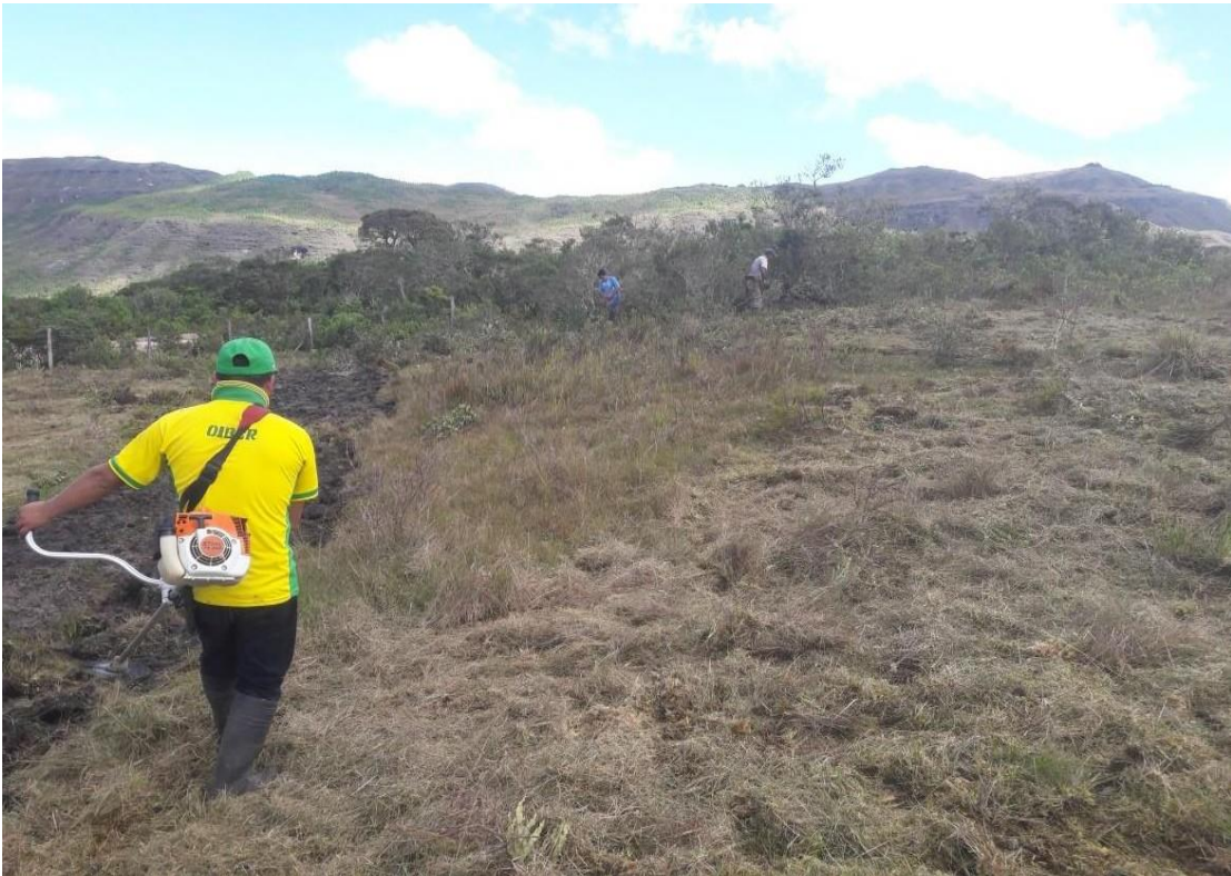
Fotografía 1. Limpieza de terreno
