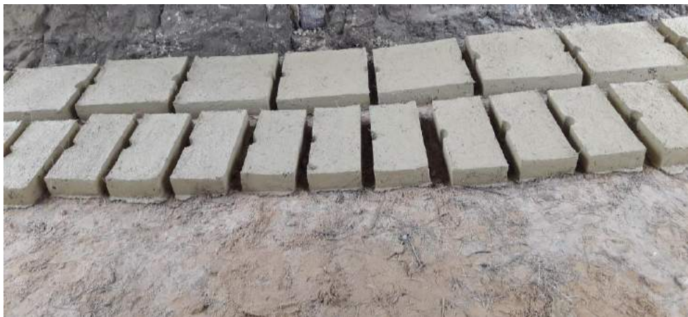
Figura 59.- Elaboración de adobe, colocado sobre una cama de arena.
