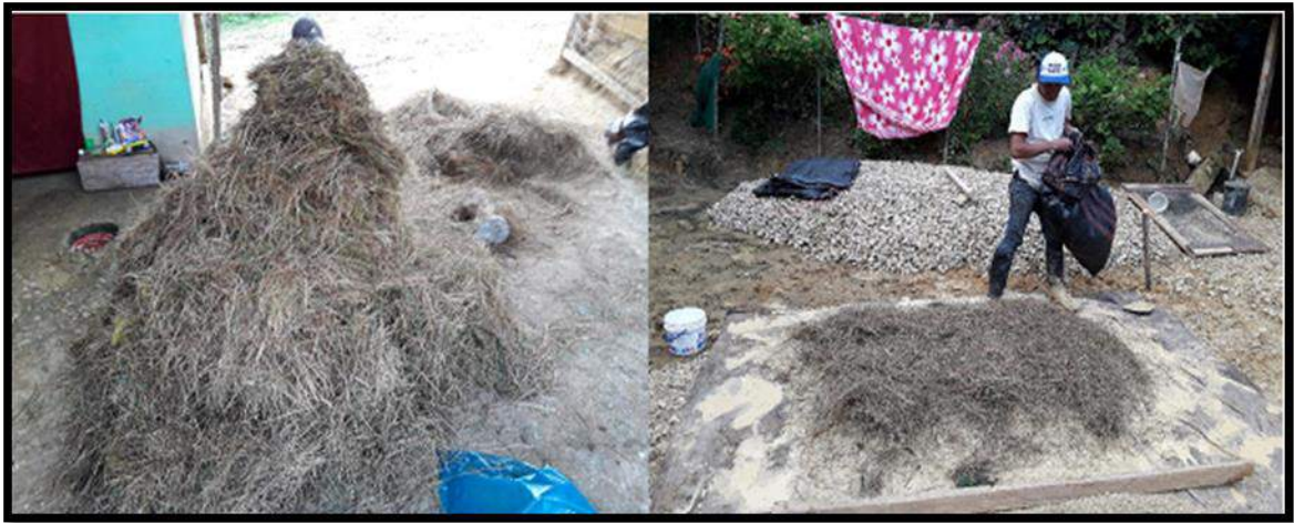
Picado y adición de paja a la mezcla de barro luego de 48 horas de dormido.
