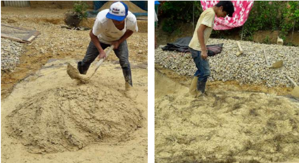
Figura 56.- Proceso de mezclado de colpar.
