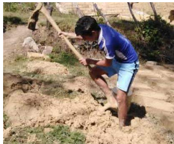
Figura 55.- Proceso de preparación de barro.
