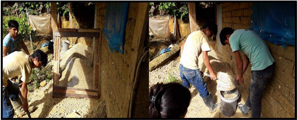
Tamizado del colpar por la malla \frac{3}{4} '' y preparación para la dosificación.
