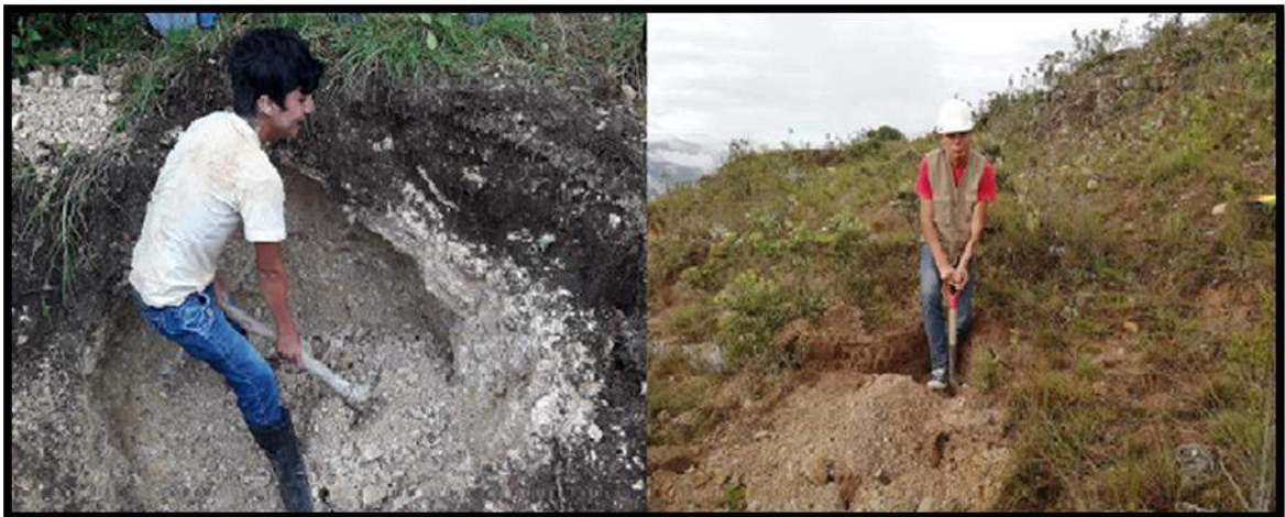
Extracción de muestra de suelos mediante el uso de calicatas.
