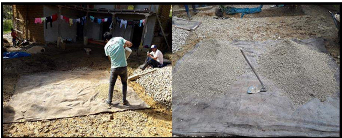
Dosificación de colpar para la elaboración de adobes.
