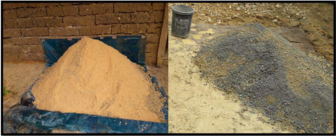
Adición de arcilla y arena para la elaboración de adobes.
