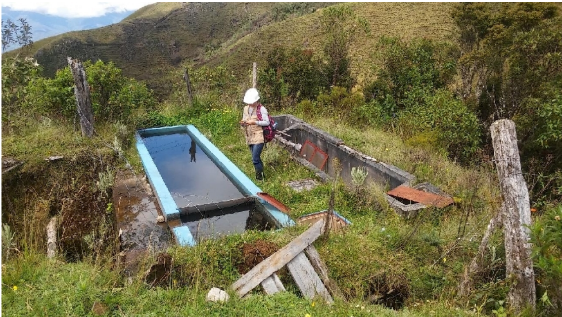
Toma de datos de ubicación de estructuras.
