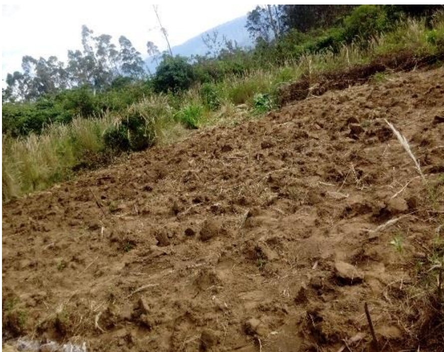
Figura 16. Preparación del terreno.
