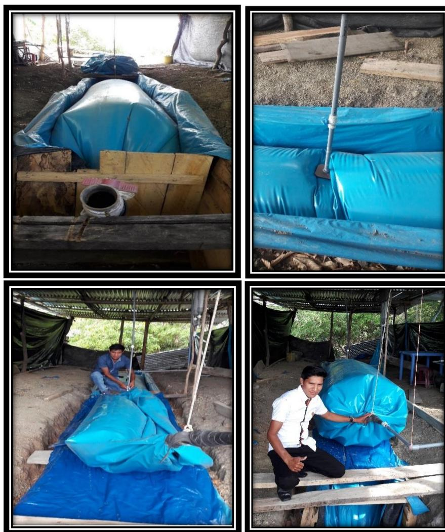
**Figura 14.** Biodigestor lleno de biogás y trasvase al gasómetro.
