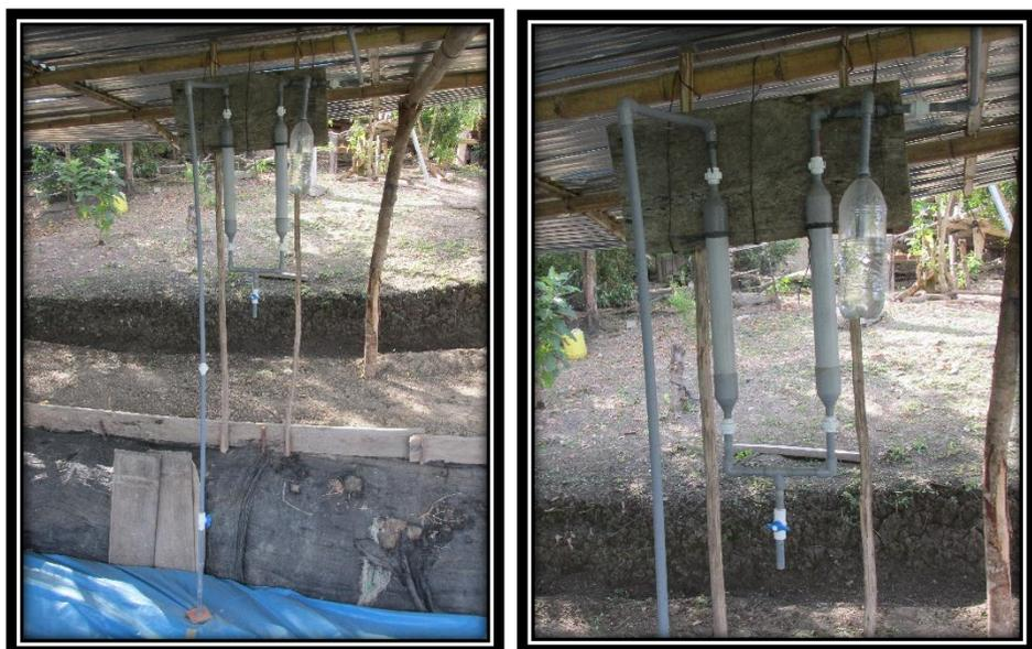
**Figura 9.** Cartuchos con clavos de hierro para eliminar el  $H_2S$  del biogás.
