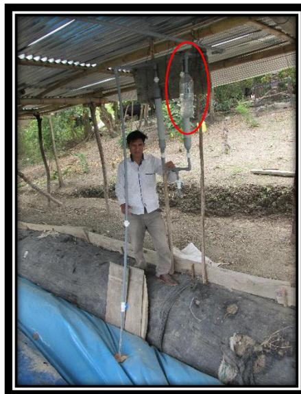
**Figura 10.** Válvula de seguridad para prefijar la presión del biogás
