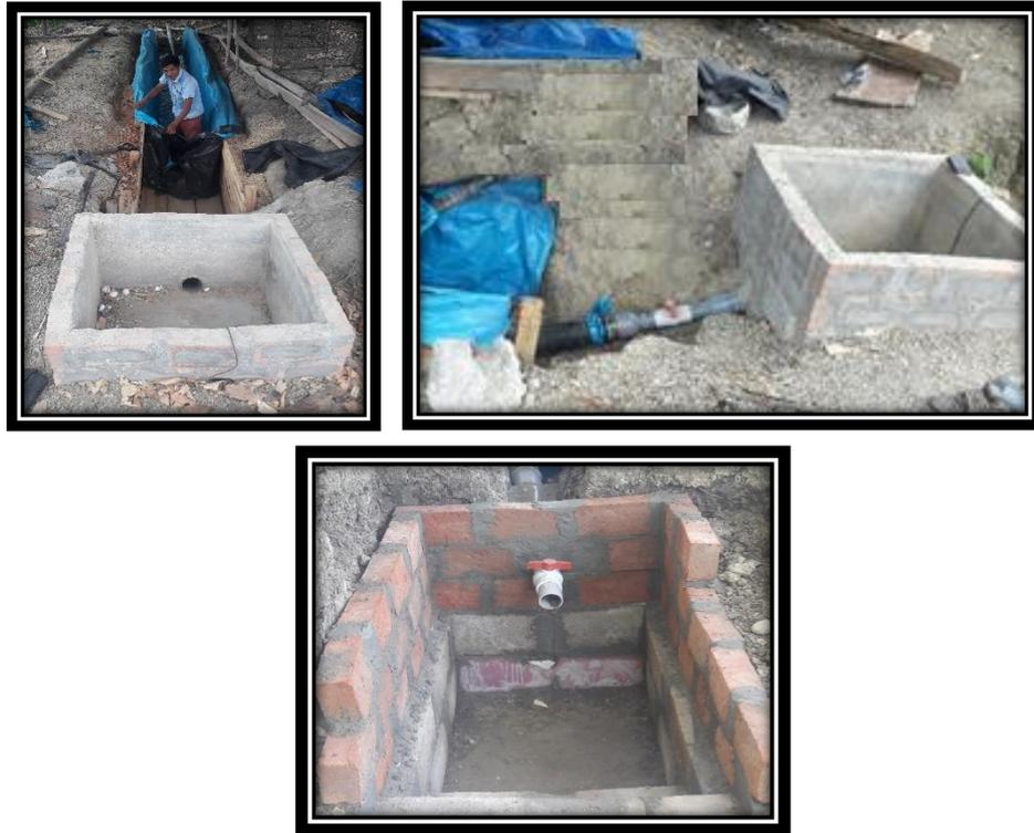
**Figura 7.** Poza de carga y poza de descarga del biodigestor.
