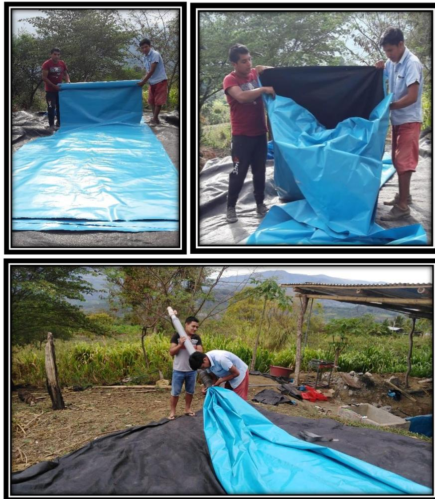
**Figura 5.** Armado del biodigestor con manga de polietileno.
