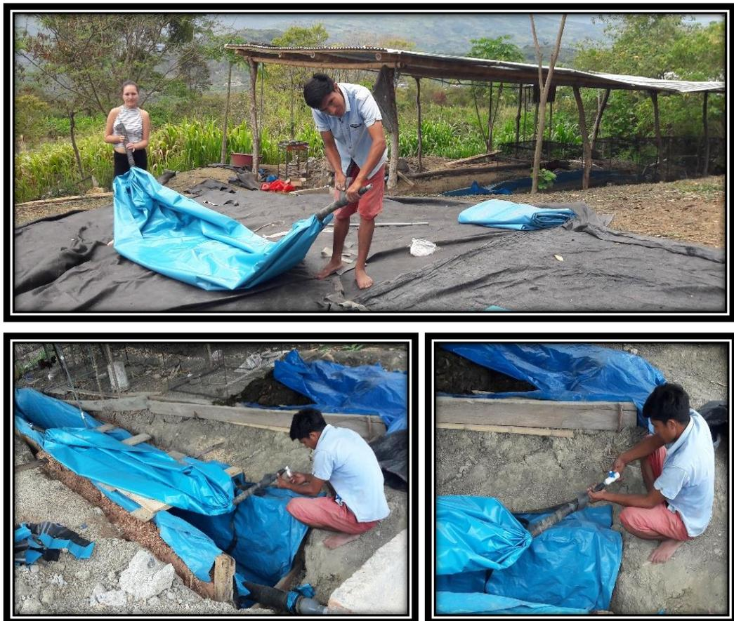
**Figura 8.** Elaboración del gasómetro
