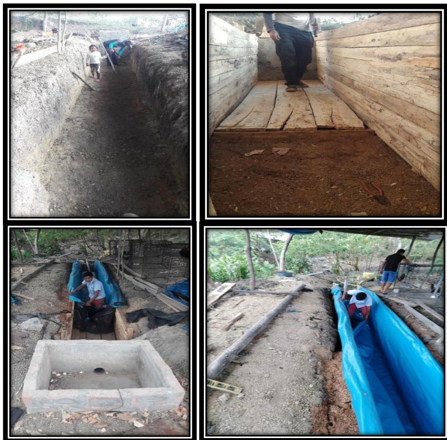
**Figura 4.** Poza para el biodigestor.
