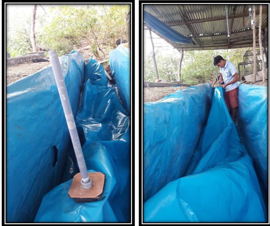
**Figura 6.** Niple para salida del biogás.
