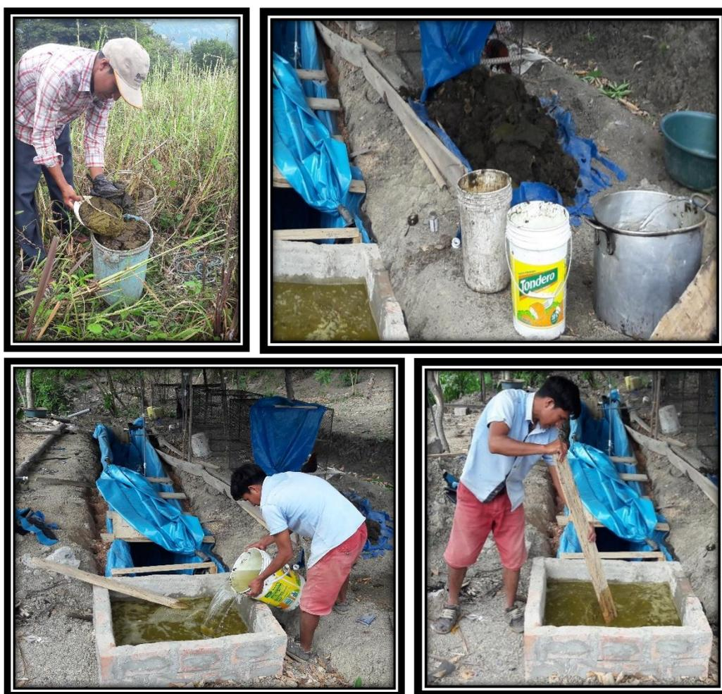
**Figura 11.** Carga del biodigestor.
