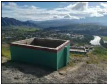
Figura 32: Etapas del sistema de agua potable
