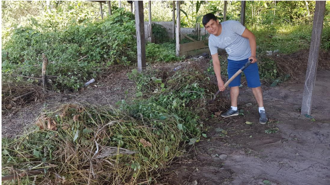
Fotografía 3. Limpieza del área donde se realizará el experimento.
