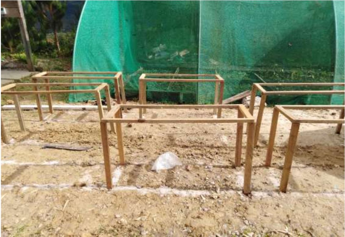
Imagen 5. Varillas de madera utilizadas para la instalación de sombra.
