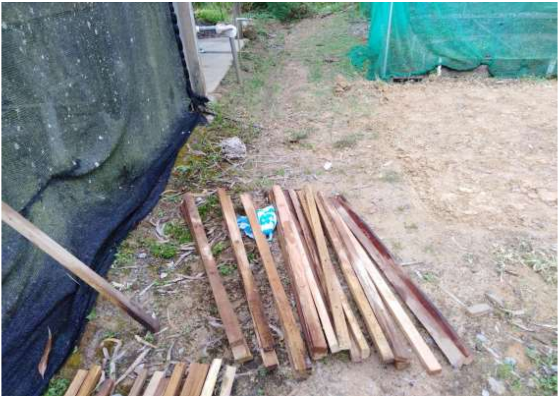
Imagen 4. Limpieza del área y obtención de materiales.
