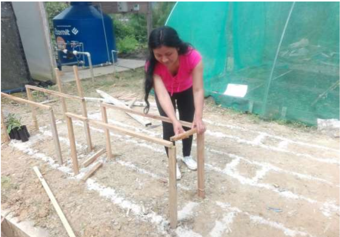
Imagen 6. Instalación de sombra en el área de investigación.
