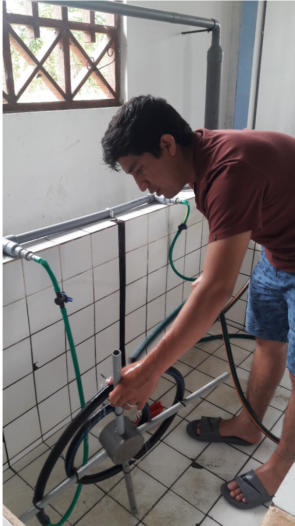
Figura 8. Instalación de mangueras de oxigenación y regulación cantidad de oxígeno
