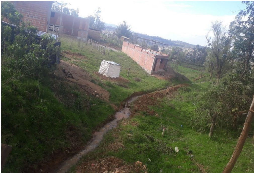
Figura 31. vivienda y poso séptico construidos en el cauce de la quebrada Zeta
