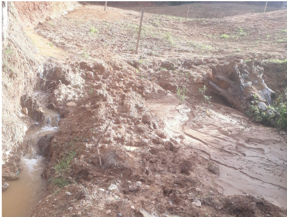
Figura 33. lotización cenca al cauce de la quebrada
