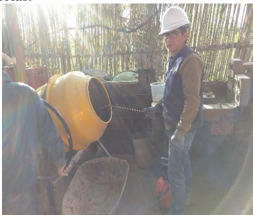
FOTO 17.- Se observa el mezclado en trompo del material para LTC.
