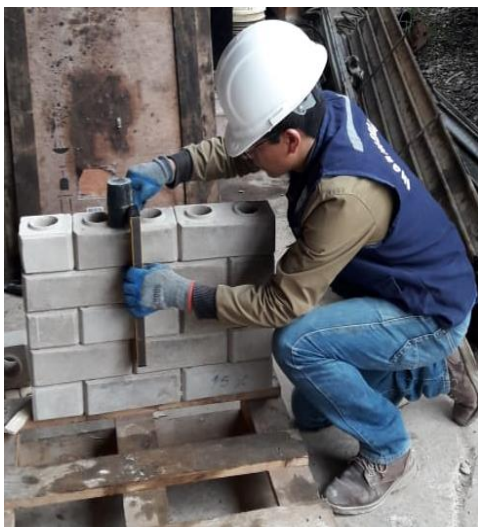
FOTO 23.- Se observa el asentado de LTC, en muretes.
