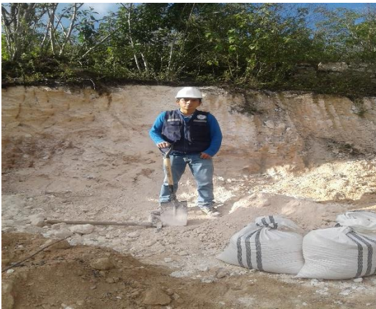
FOTO 3.- Se observa la extracción de material de cantera de la Villa San Juan para ser llevado a Laboratorio.
