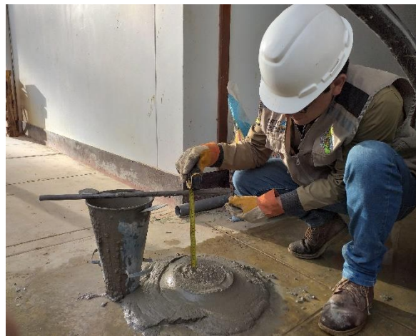
FOTO 22.- En la imagen se observa medida de slump del grout fino.
