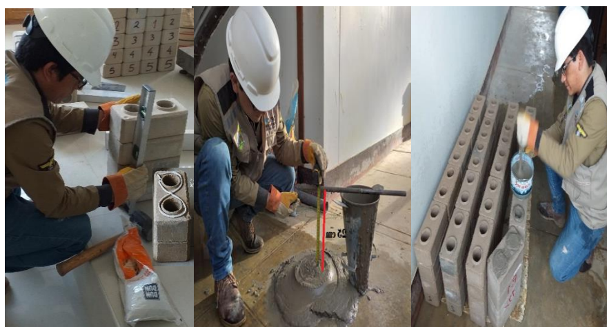
Figura 21. Asentado, medida de slump de grout fino y llenado de alveolos.
