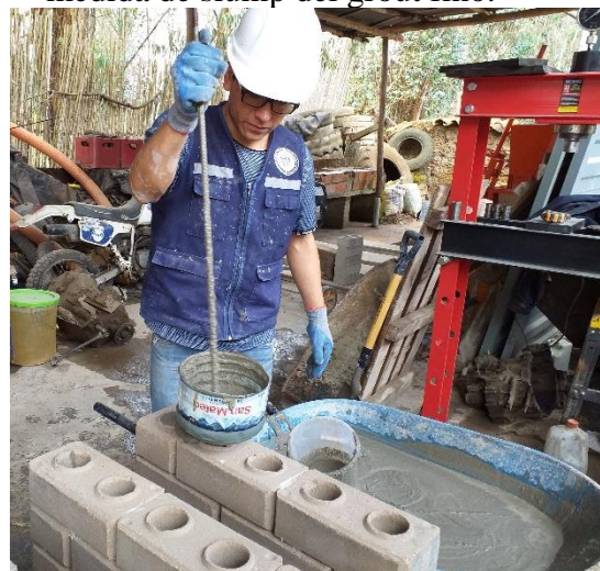
FOTO 24.- Se observa el llenado de grout fino en alveolos de muretes.
