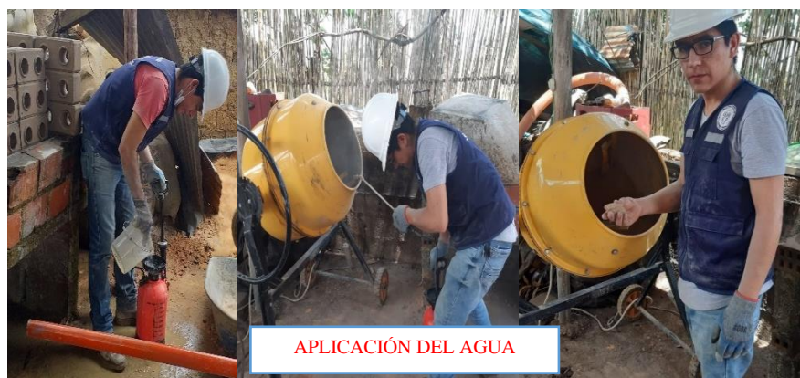
Figura 18. Aplicación del agua a la mezcla suelo cemento.
