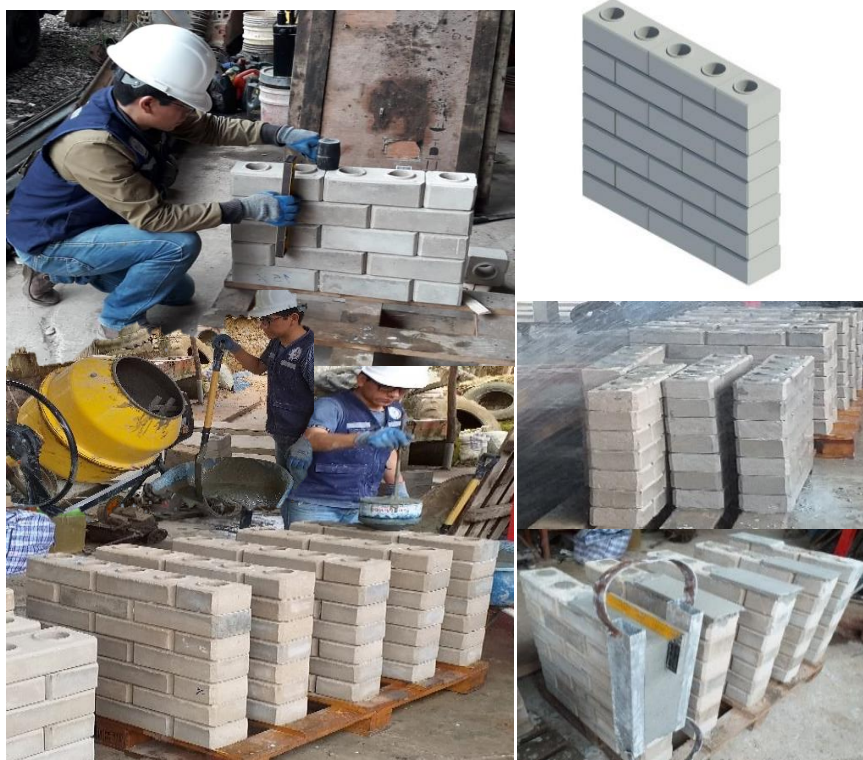
Figura 23. Vista de armado de muretes de LTC.
