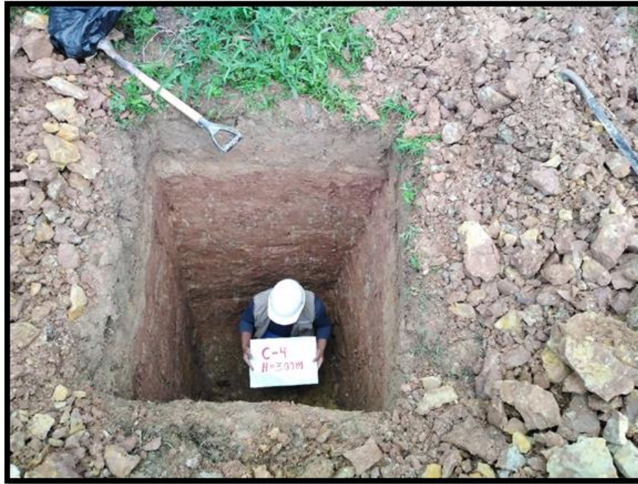
Fotografía 04: Se observa la excavación de la calicata 04.
