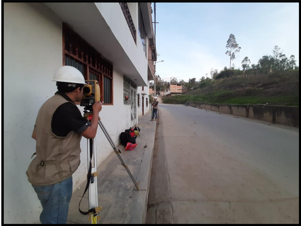
Fotografía 08: Se observa la realización de la lectura de puntos topográficos.
