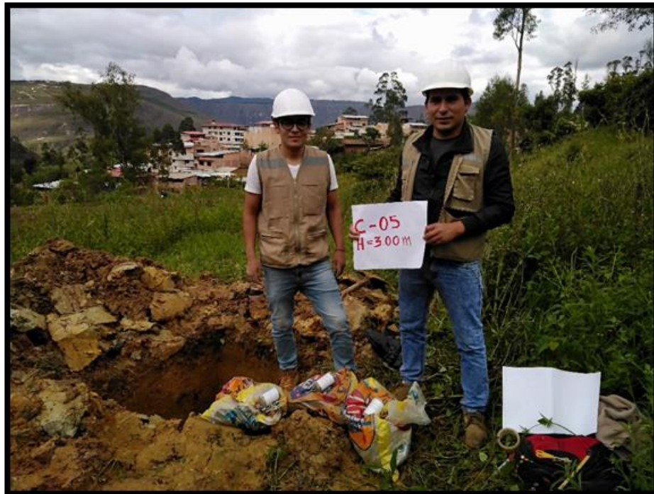
Fotografía 05: Se observa la excavación de la calicata 05.
