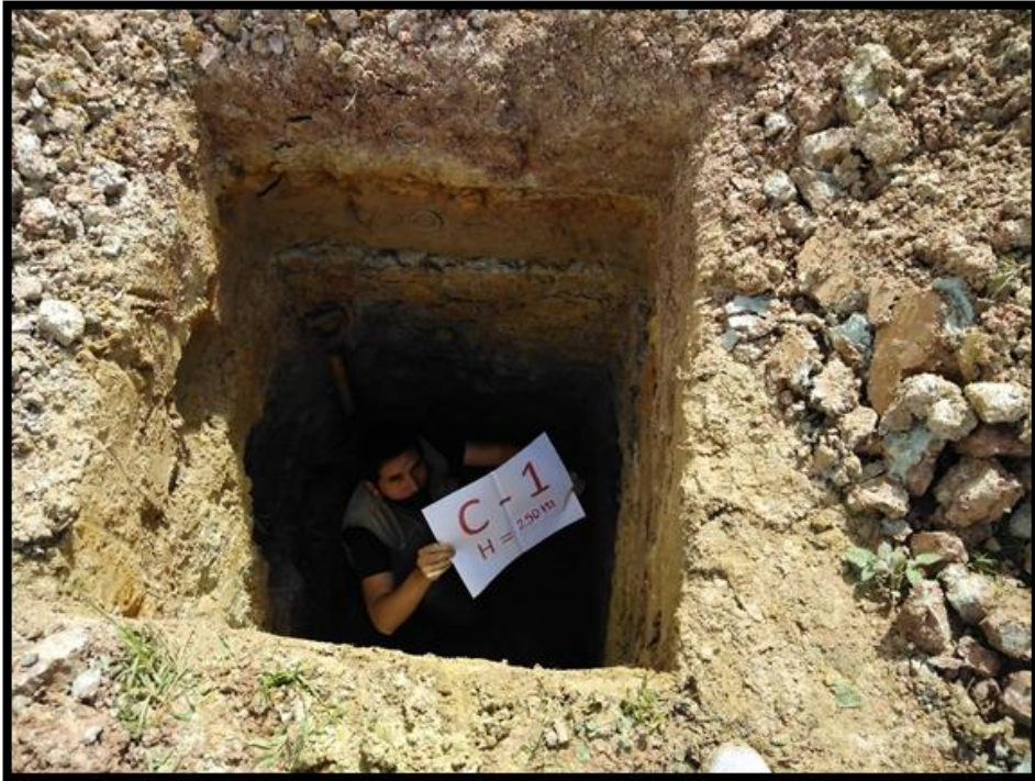
Fotografía 01: Se observa la excavación de la calicata número 01.
