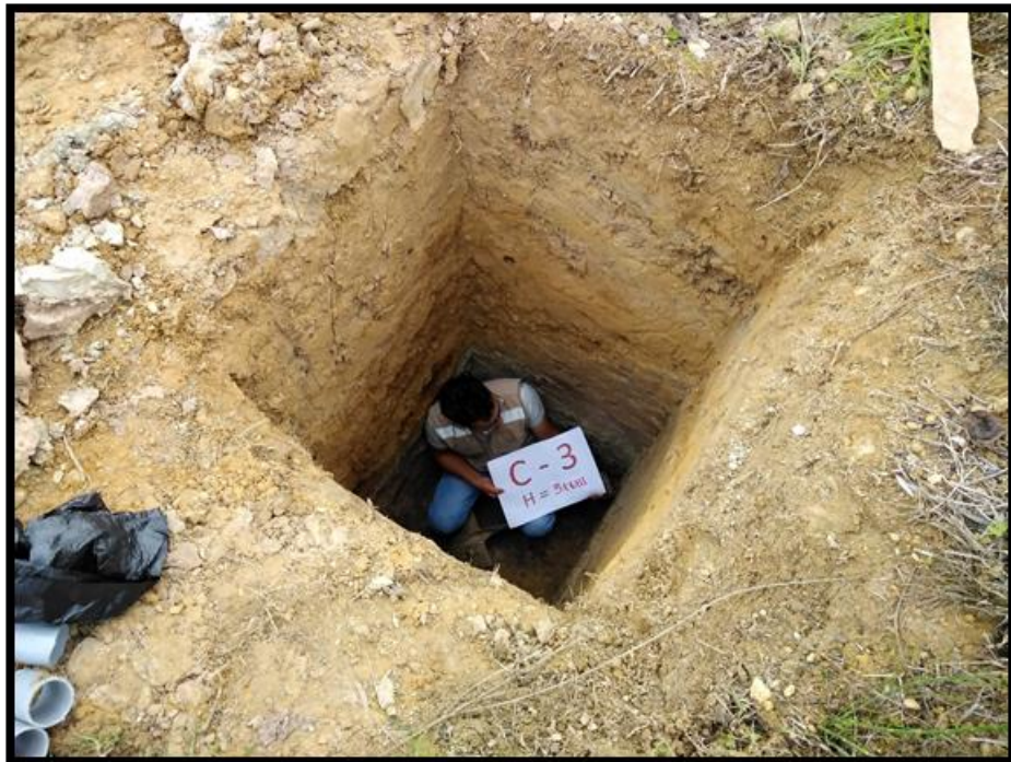
Fotografía 03: Se observa la excavación de la calicata 03.
