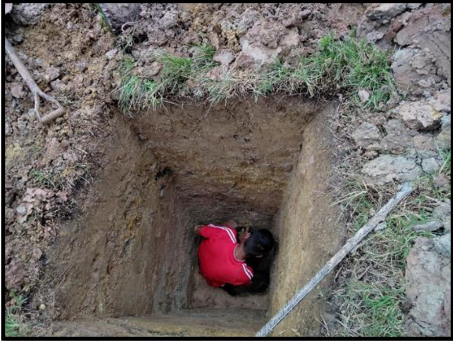
Fotografía 02: Se observa la excavación de la calicata 02.
