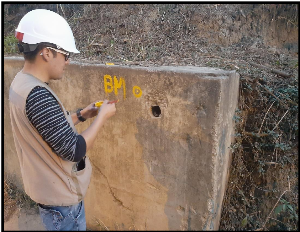
Fotografía 07: Se observa la monumentación del BM-01.
