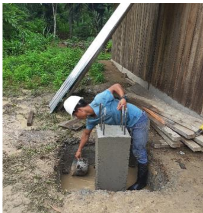
11. Desencofrado de la columna de apoyo
