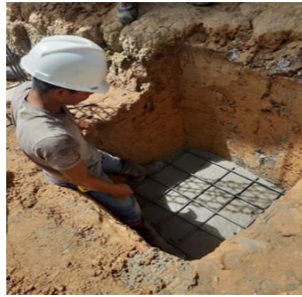
8. Llenado de la base para el prototipo.
