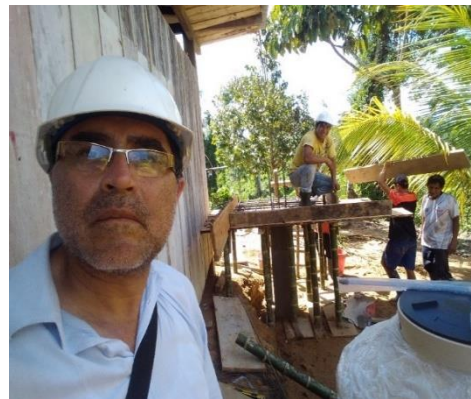
12. Armado de la losa de apoyo.
