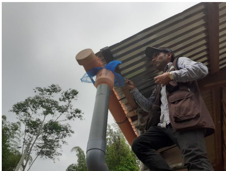
Figura 11. Mantenimiento de los sistemas de captación de agua.
