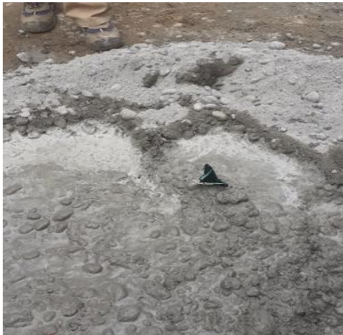
9. Preparación del concreto
