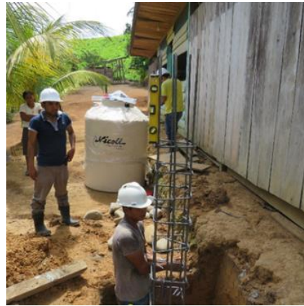
10. Armado de las columnas
