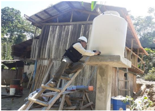
18. Centrado de los tanques
