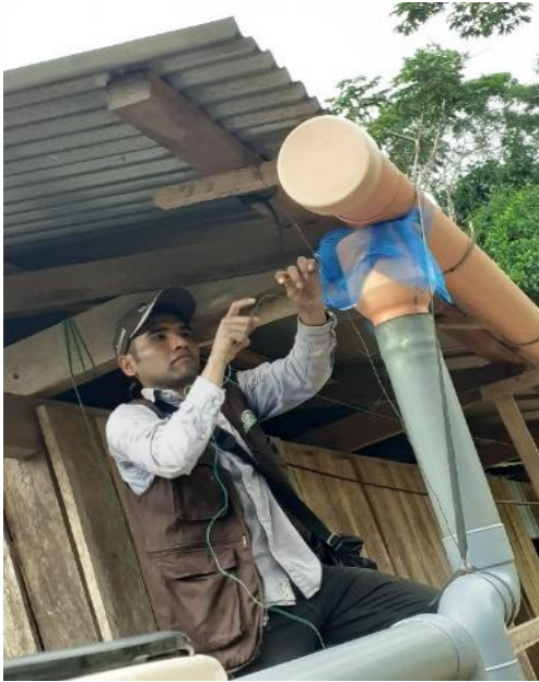
16. Instalación de canaletas y coladores
