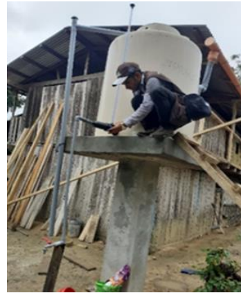
19. Instalación del sistema
