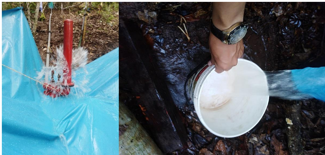
Fotografía 6. BAH en funcionamiento y medición de caudal de rebose.
