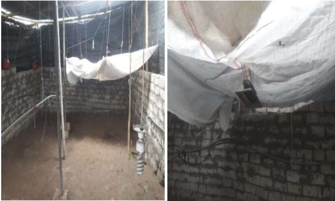
Fotografía 11. Instalación de campana y techo falso.
