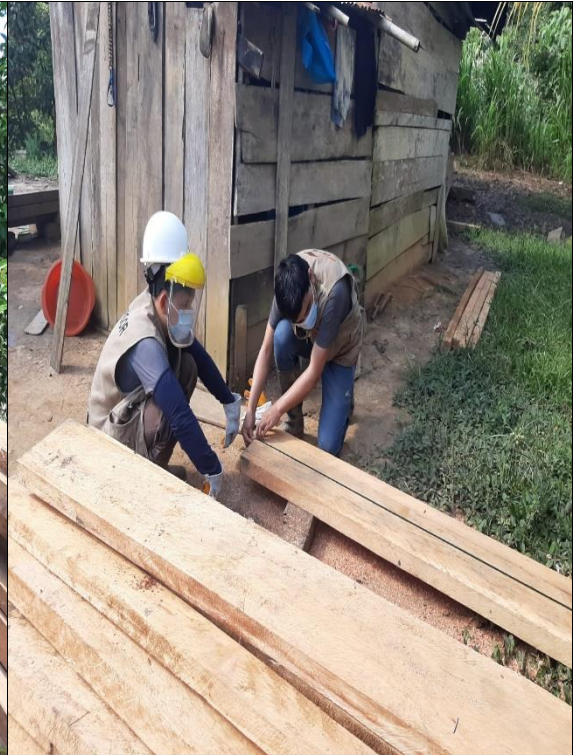
Foto 14: Trazado de tablones, para la obtención de viguetas.
