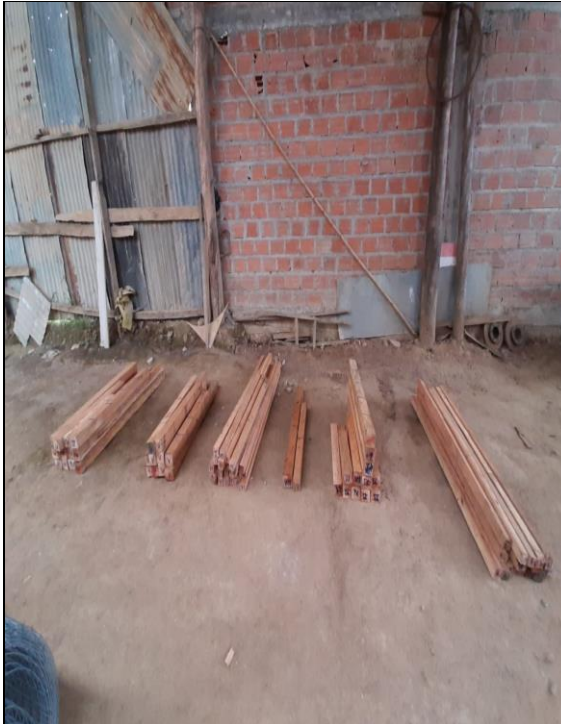
Foto 21: Viguetas descargadas y acondicionadas en carpintería, ciudad de Chachapoyas.
