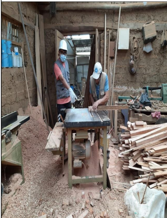
Foto 23: Acondicionamiento de viguetas en sus dimensiones reales.
