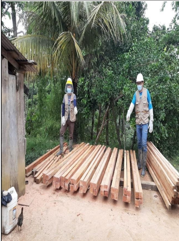
Foto 17: Acondicionamiento de las viguetas que se obtuvieron.
