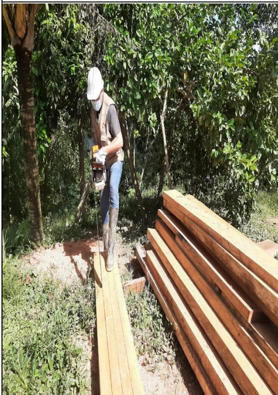
Foto 15: Corte de tablones para la obtención de viguetas.
