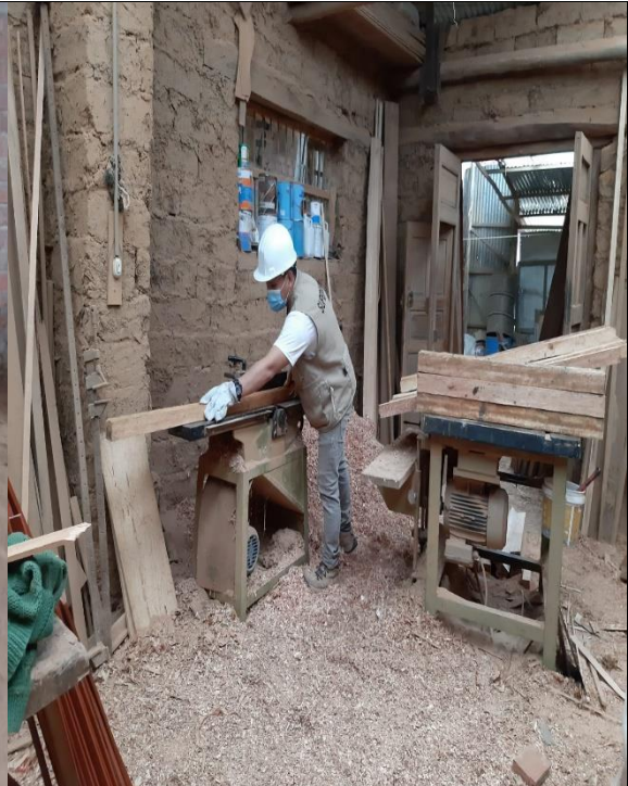
Foto 22: Cepillado de viguetas en carpintería.
